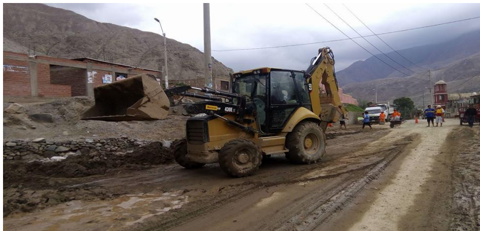
Figura 4. Maquinaria pesada en limpieza de la carretera por Niño Costero Fuente: Archivo Oficina de Defensa Civil Municipalidad Distrital de Pacarán
