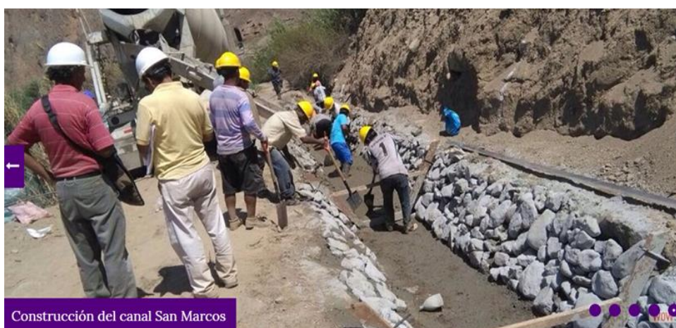
Figura 7. Construcción del canal San Marcos
