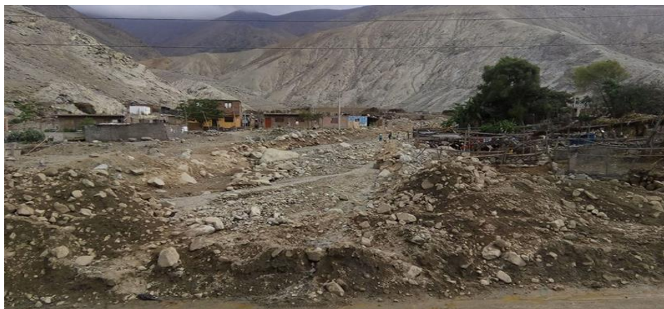
Figura 5. Huayco y Daños en viviendas y carretera por Niño Costero
