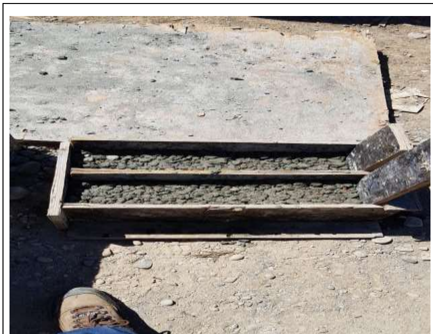
Figura 5. Preparación del concreto poroso
