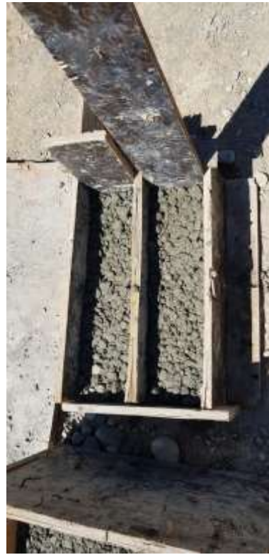
Fotografía de la elaboración del encofrado del concreto poroso
