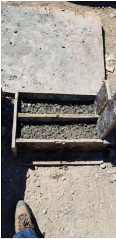
Fotografía de la elaboración del encofrado del concreto poroso
