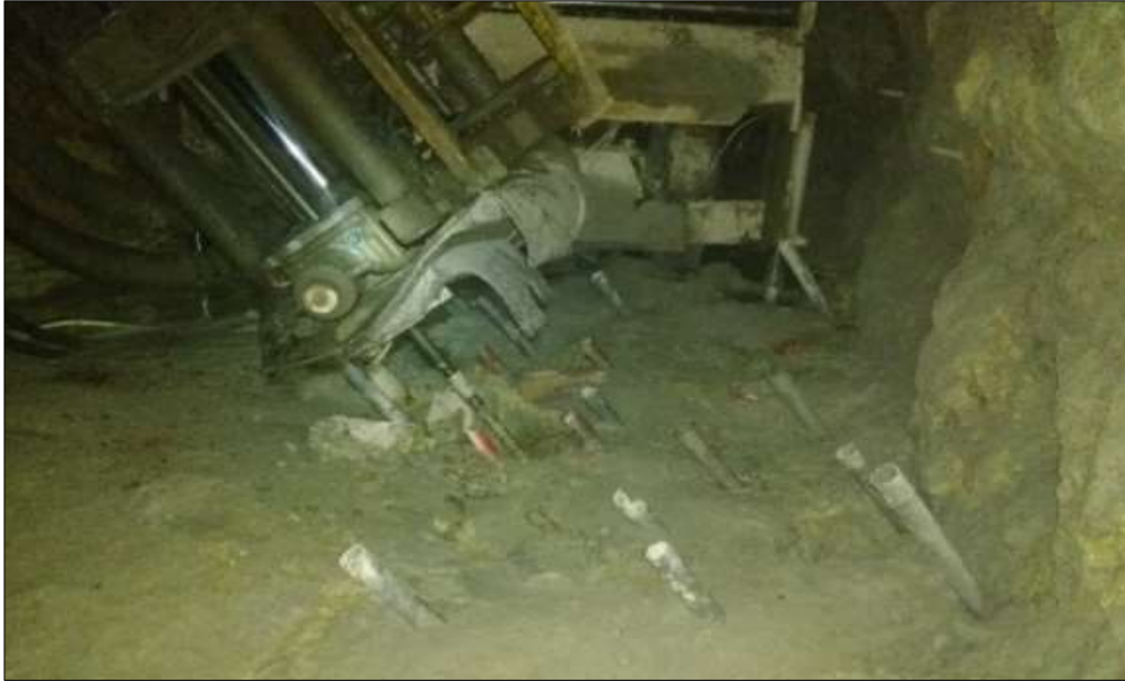
Figura 18. Perforación de taladros largos equipo J – 310 (Simba S7D)
