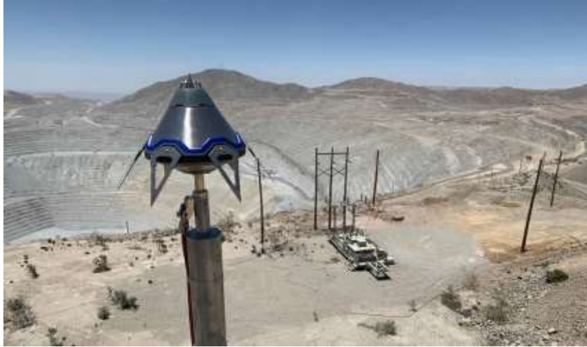
Figura 16. Pararrayo con dispositivo de cebado
