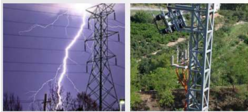
Figura 3. Descargas eléctricas atmosféricas
