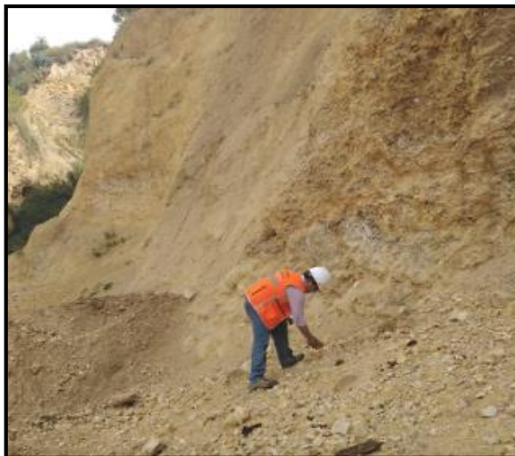
Figura 40: Toma de muestras de las canteras Carhuapaccha (km 04+460) y de la cantera Socos (km 08+440).
