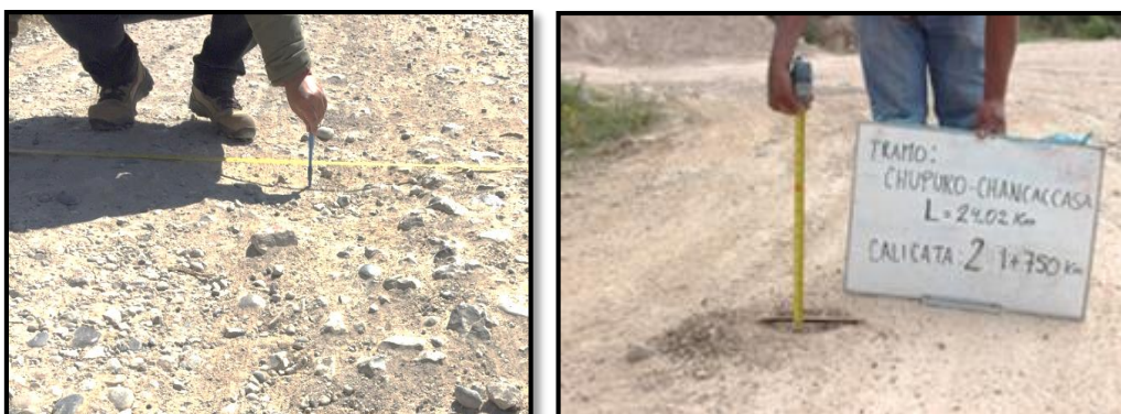
Figura 27: Ejecución de la calicata C-2 de la carretera Chupuro – Chancaccasa.
