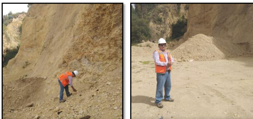
Figura 28: Toma de muestras de las canteras Carhuapaccha (km 04+460), y de la cantera Socos (km 08+440).
