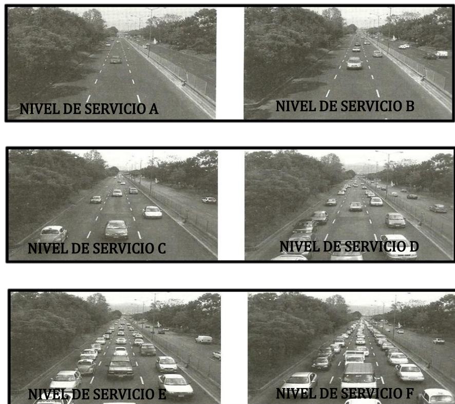
Figura 14. Niveles de Servicio
