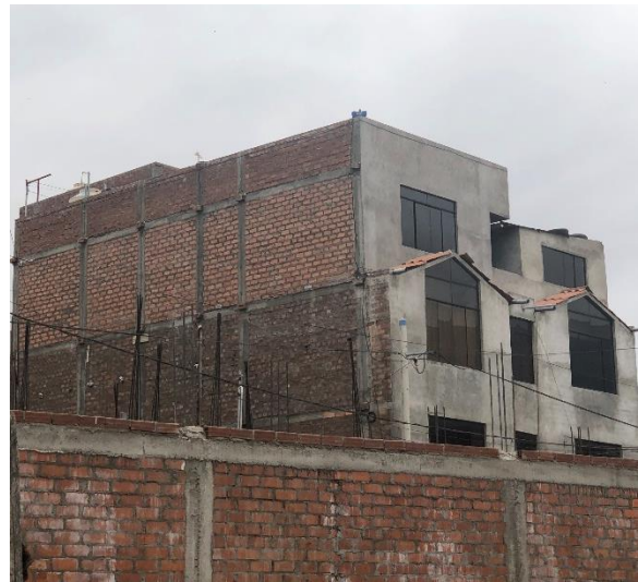
Figura 6. Vivienda con empleo de ladrillos artesanales en los dos primeros niveles y ladrillos tubulares en el tercer nivel, ubicación: Jr. Miraflores, Urb. Pielago.
