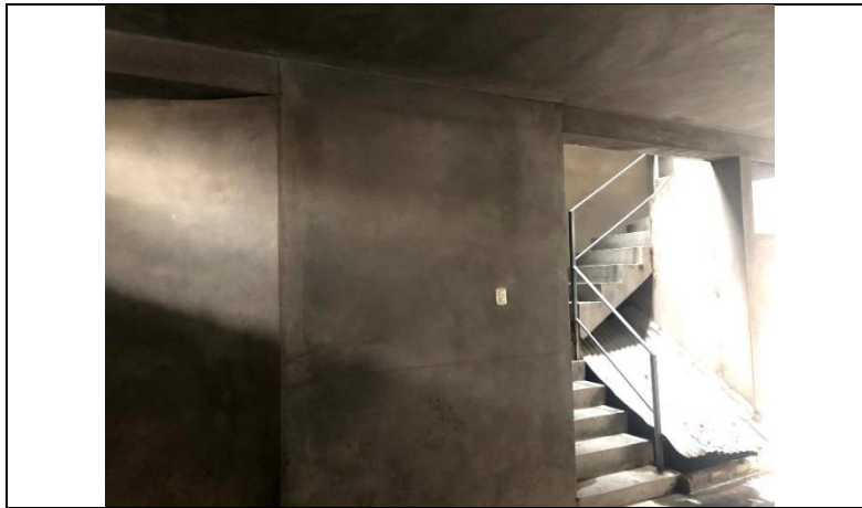
Figura 36. Viga peraltada en eje B.
