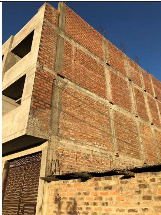
Figura 7. Vivienda con empleo de ladrillos artesanales en los dos primeros niveles y ladrillos tubulares en los últimos niveles, ubicación: Calle Los Pinos, Palian.
