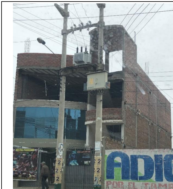
Figura 3. Vivienda con empleo de ladrillos artesanales en los dos primeros niveles y ladrillos tubulares en el tercer nivel, ubicación: Calle Marte, Chorrillos.
