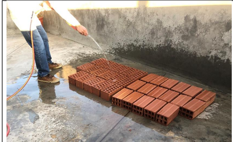
Figura 38. Riego de ladrillos. Fuente: Propia.
