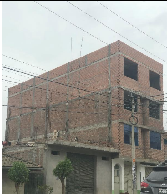
Figura 5. Vivienda con empleo de ladrillos artesanales en los tres primeros niveles y ladrillos tubulares en el último nivel, ubicación: Av. José Olaya, Urb. Pielago.
