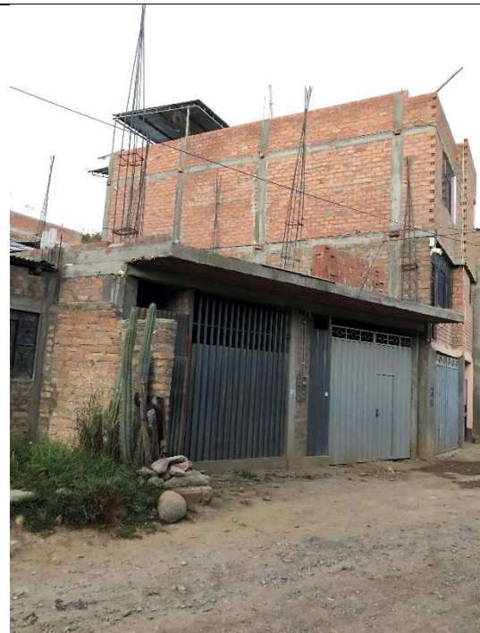
Figura 8. Vivienda con empleo de ladrillos artesanales en los dos primeros niveles y ladrillos tubulares en el tercer nivel, ubicación: Calle Ricardo Palma, Palian.
