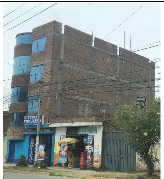
Figura 4. Vivienda con empleo de ladrillos artesanales en los dos primeros niveles y ladrillos tubulares en los últimos niveles, ubicación: Av. Calmell del Solar, Chorrillos.
