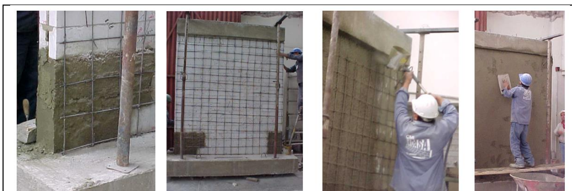
Figura 62. Trabajo referencial del procedimiento de reforzamiento con malla electrosoldada.
