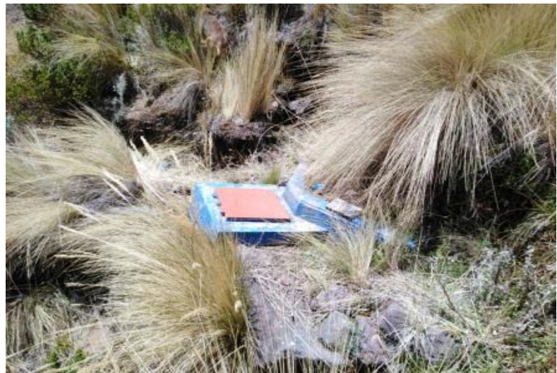
Figura 30. Foto del sistema de Captación 1 Ccorihuayrachina.
