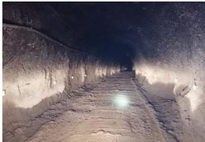
Figura 64. Tramo OP 1-5 esquinas en buenas condiciones
