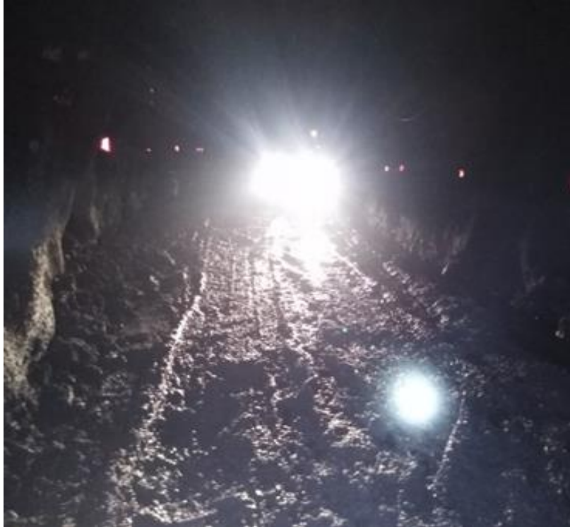
Figura 33. Vía principal OP1 niv. 3600 en malas condiciones
