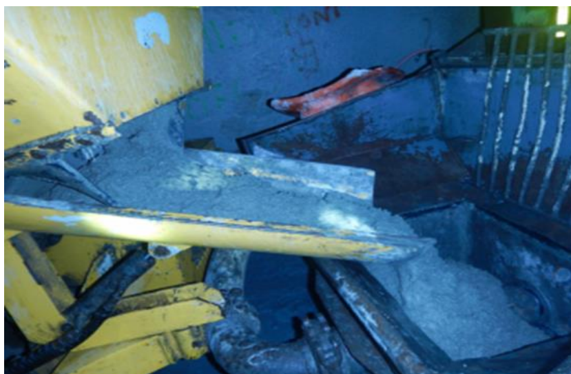
Figura 44. Operación de bombeo con la parrilla levantada
