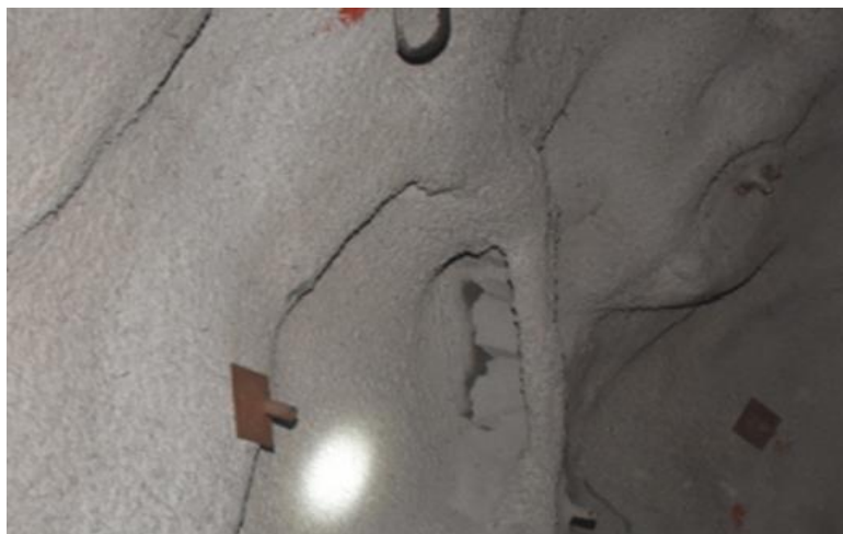
Figura 39. Zonas abiertas sin proyectar que permiten el oreo
