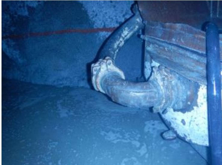
Figura 20. Codo reparado con soldadura
