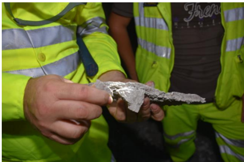
Figura 35. Espesor de proyección inferior al exigido
