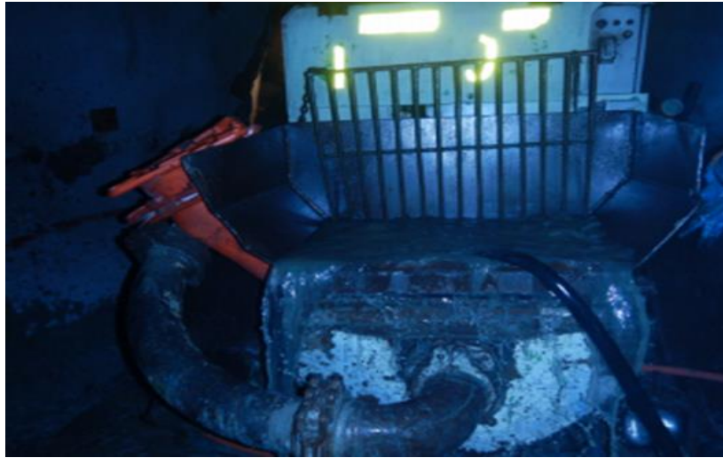
Figura 45. Limpieza de la tolva con la parrilla levantada
