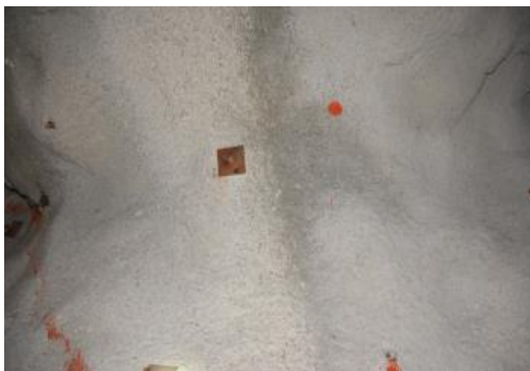
Figura 25. Diferentes coloraciones del hormigón proyectado
