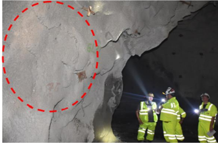
Figura 37. Juntas entre capas proyectadas
