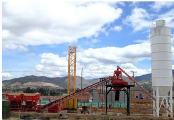
Figura 18. Instalación de planta AMP25 con mezclador planetario elevado
