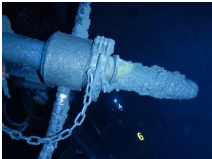
Figura 21. Codo reparado con soldadura
