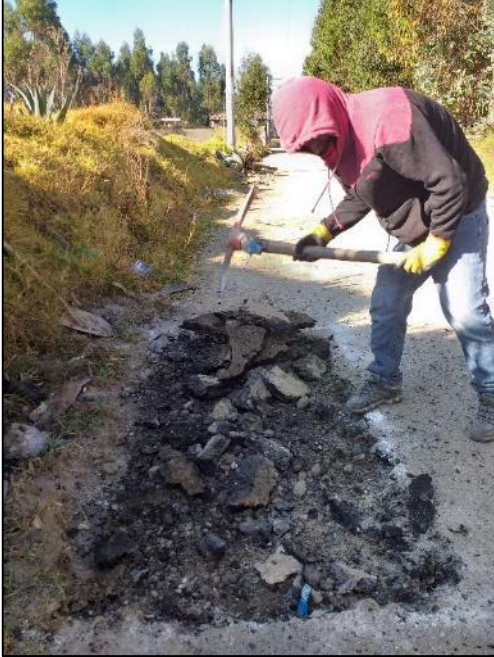
Fotografía N° 1: Extracción de la carpeta asfáltica de la Av. Andrés A. Cáceres
