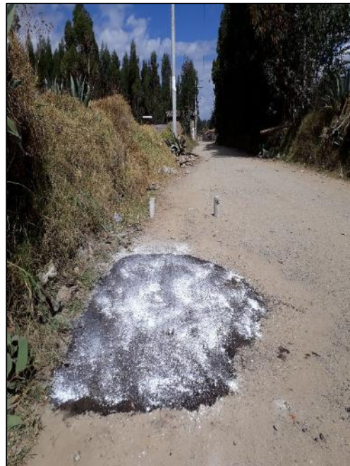
Fotografía N° 4: Reposición total de la carpeta asfáltica reciclada.
