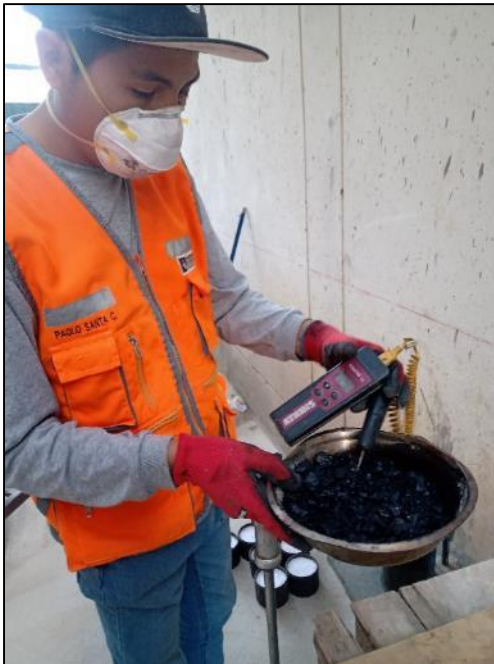
Fotografía N° 8: control de la temperatura de compactación.
