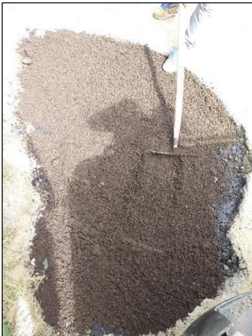
Fotografía N° 3: Colocación de la mezcla asfáltica en frío
