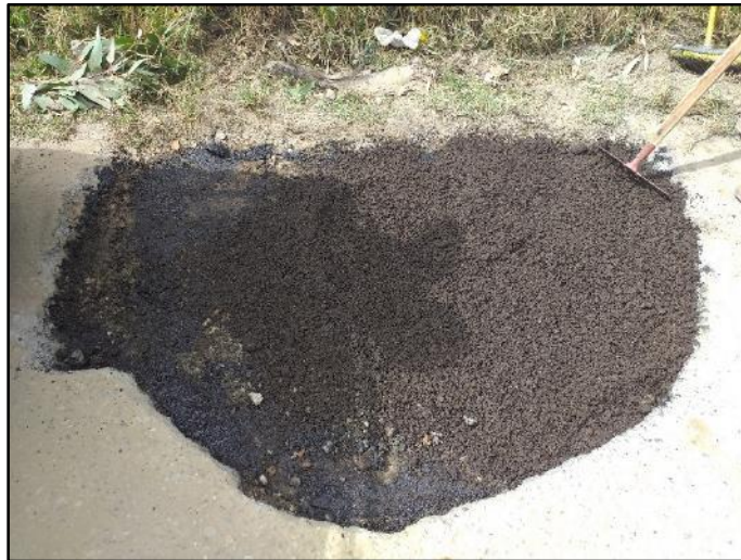
Figura 6. Reposición de la carpeta asfáltica extraída con emulsión asfáltica
