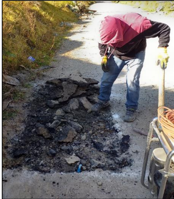
Figura 5. Extracción manual de la carpeta asfáltica
