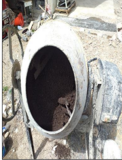
Fotografía N° 2: Preparación de la emulsión asfáltica
