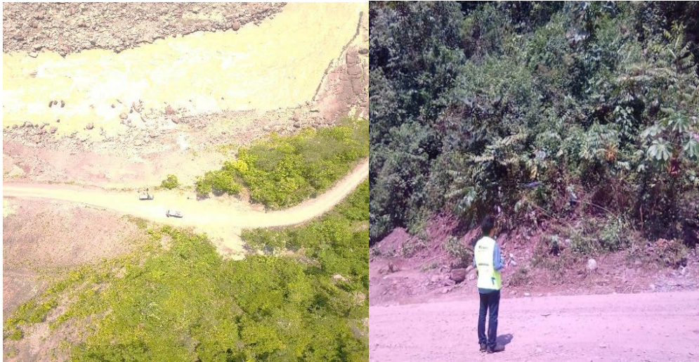
Figura 63: Levantamiento topográfico del talud en estudio.
