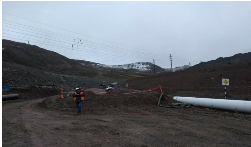
Figura 83. Paralización de labores en obra por causa de la lluvia intensa.
