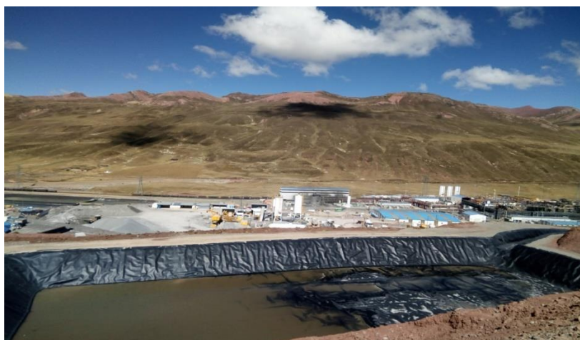
Figura 50. Instalación de geotextil y geomembrana en poza de contingencia N° 02.
