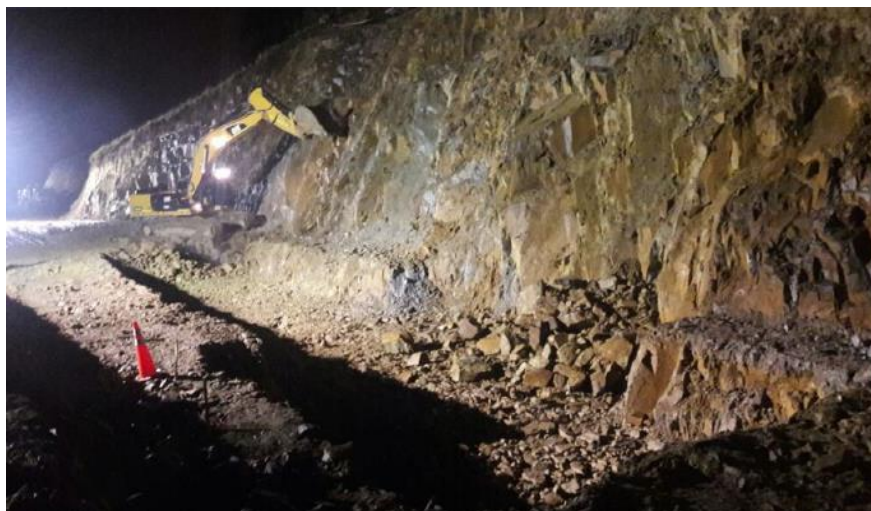
Figura 69. Perfilado y corte de material en plataforma de estación disipadora.
