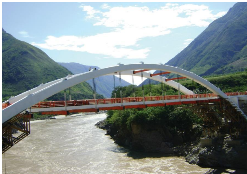
Figura 06. Obra Civil. Puente Salinas, Amazonas - Perú.
