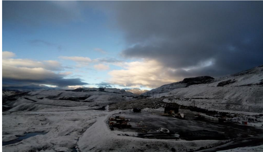
Figura 82. Paralización de labores en obra por causa de la nevada.
