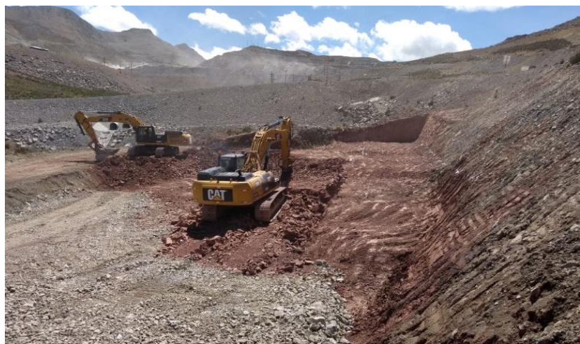
Figura 48. Excavación masiva en roca de la poza de contingencia N° 01.
