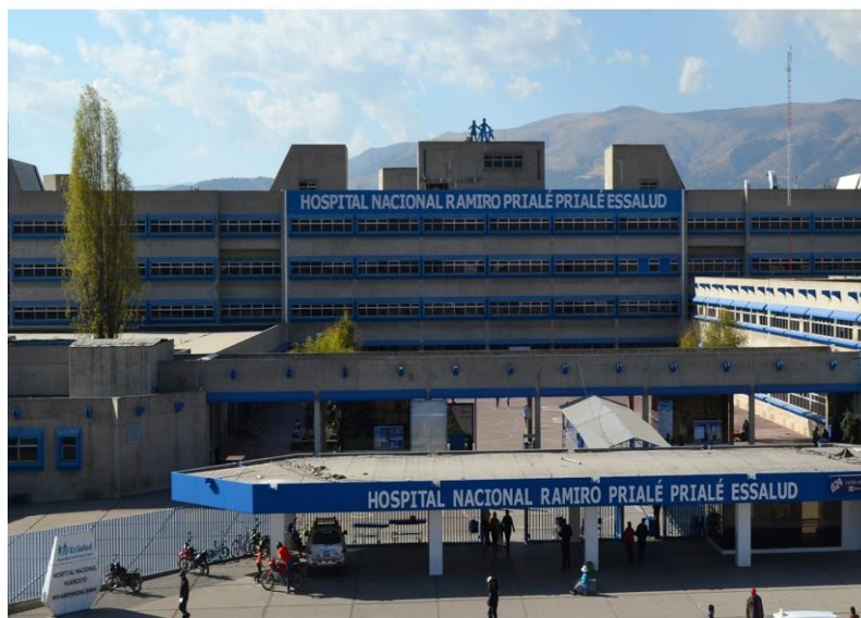
Figura 04. Construcción no habitacional. Hospital Nacional Ramiro Prialé Prialé ESSALUD, Huancayo - Perú.
