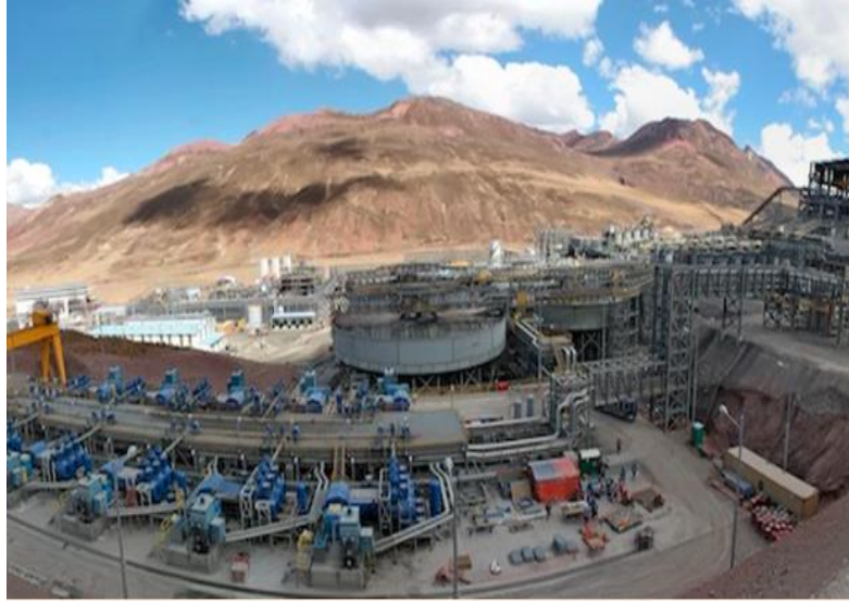
Figura 05. Construcción industrial. Construcción de planta de procesamiento de minerales de Minera Chinalco - Perú.
