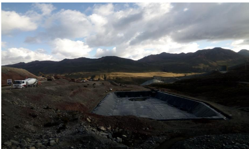
Figura 49. Instalación de geotextil en poza de contingencia N° 01.
