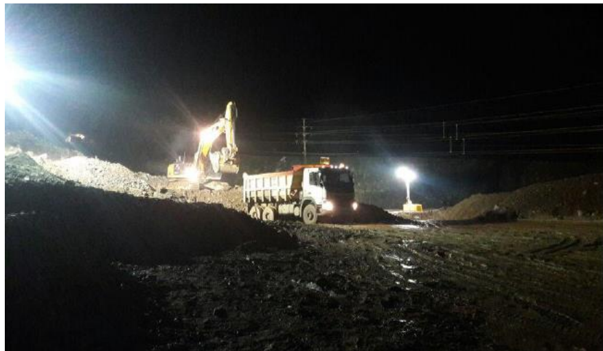
Figura 68. Corte y carguío en by pass cantera.
