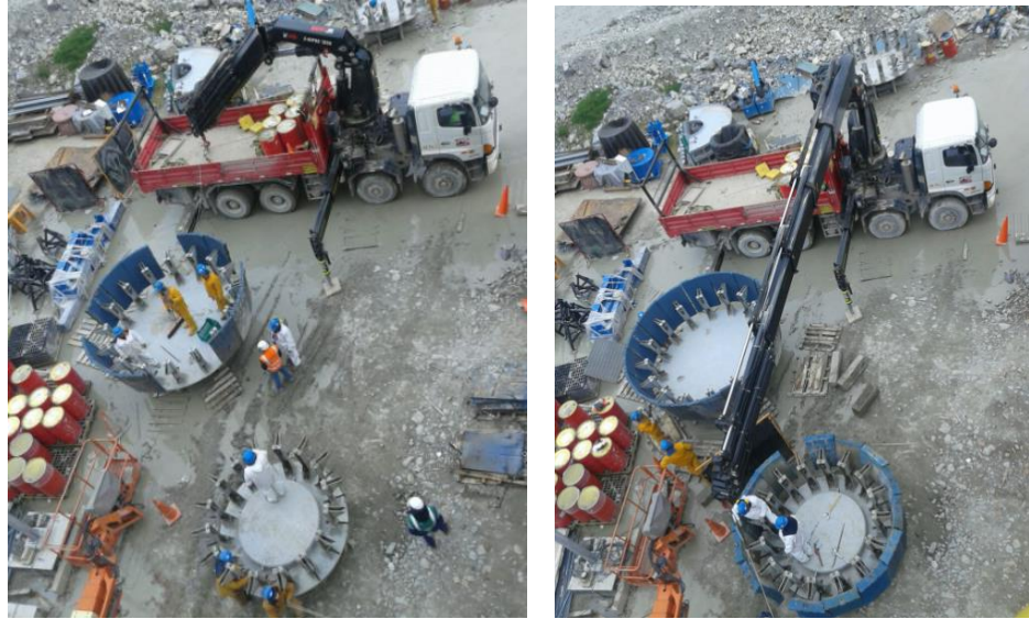
Figura 77. Etapa de pre armado.
