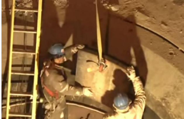
Figura 20. Instalación de cóncavos, uno a la vez.
