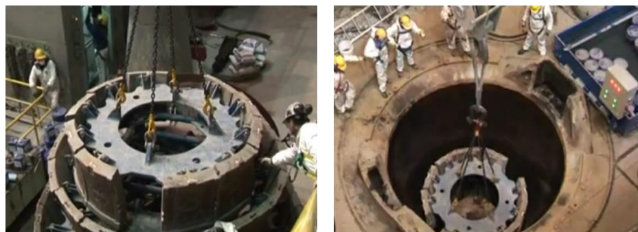
Figura 22. Instalación de revestimientos cóncavos con un aparejo plataforma.
