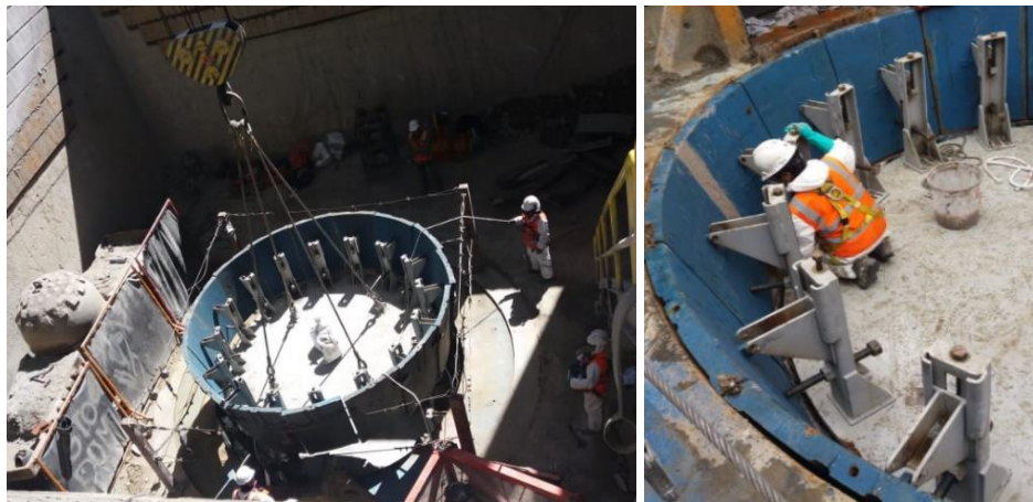
Figura 78. Etapa de armado.
