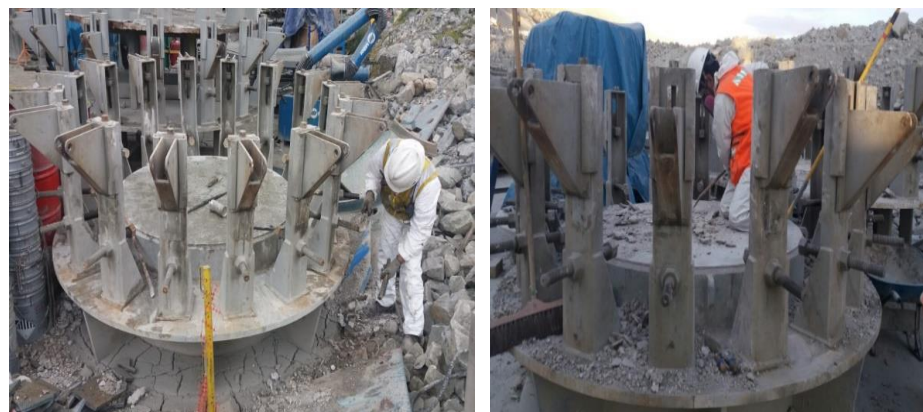
Figura 80. Revisión final del aparejo estructural.
