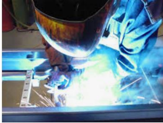
Figura 74. Soldeo de estructuras.
