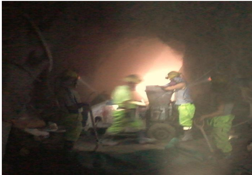
Figura 21. Sostenimiento del By Pass 759 NW
