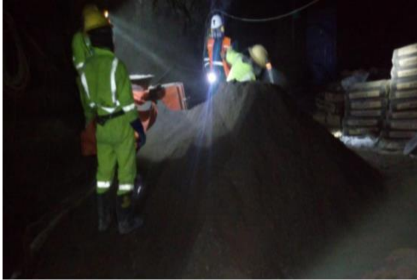
Figura 20. Mezcla de arena, cemento y dramix
