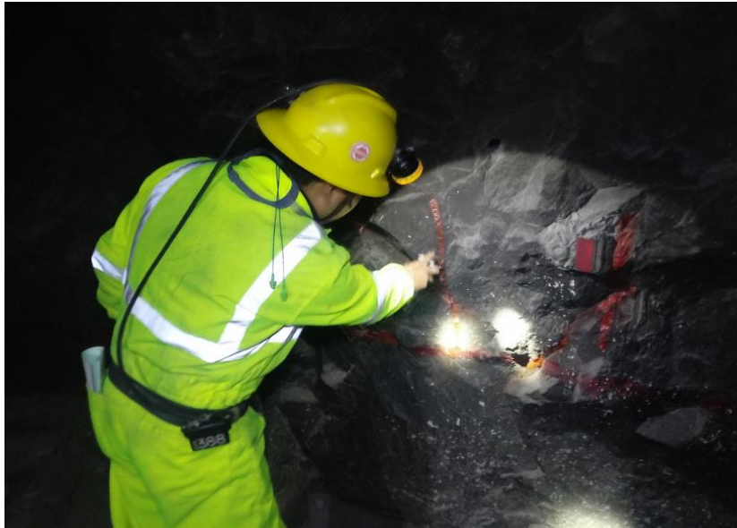
Figura 15. Mapeo geomecánico del By Pass 759 NW
