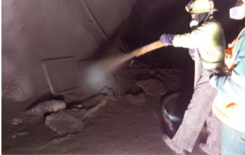
Figura 17. Toma de muestra de shotcrete por vía seca
