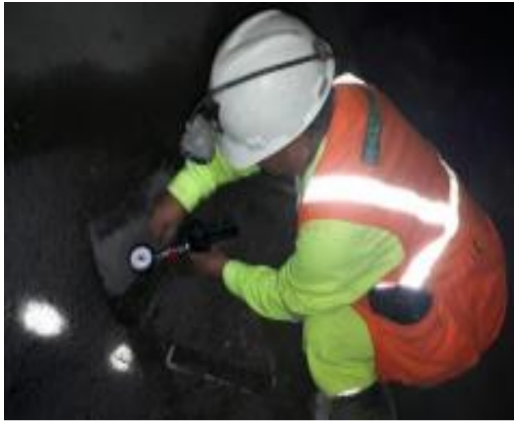
Figura 24. Resistencias a la compresión (en MPa) del shotcrete in situ
