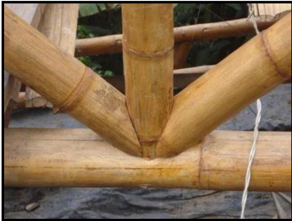
Imágen 11: – unión de guadua con el corte de pico de flauta
