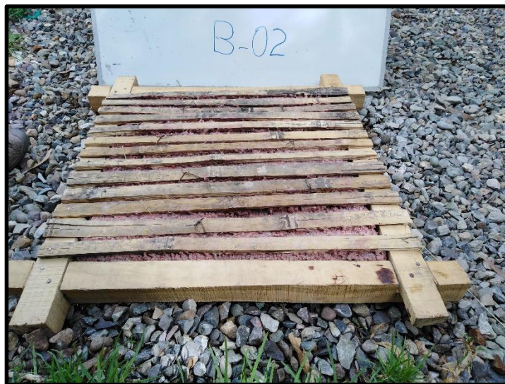
Ilustración 2: Panel B-02 de cañas en sentido horizontal, si presenta fisuras y agrietamientos el mortero quedo adherido de manera uniforme la separacion entre cañas es superior a 1.5cm
