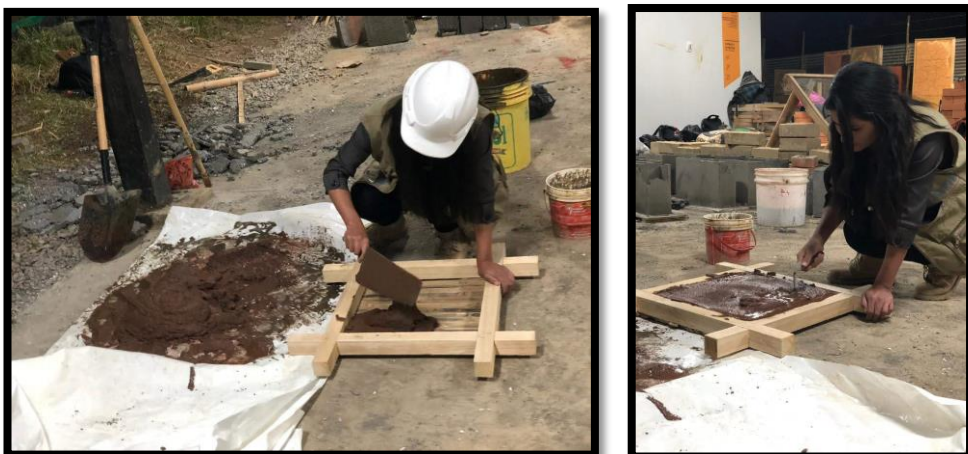
Fotografía 5: relleno de mortero
