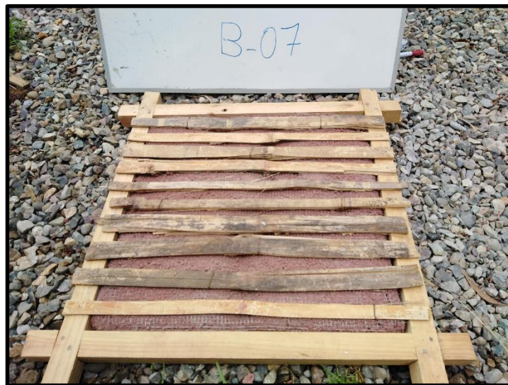
Ilustración 7: Panel B-07 de cañas en sentido horizontal, presenta fisuras leves y un agrietamiento en la esquina inferior el mortero quedo adherido de manera uniforme, se usó una malla de plástico no permite que el mortero se una a las cañas.
