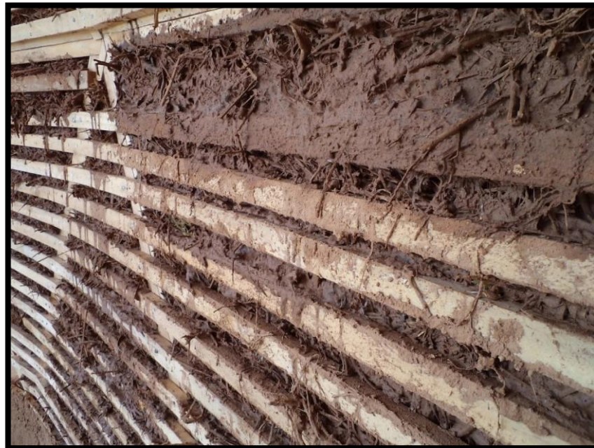
Imágen 3: Paredes de Quincha
