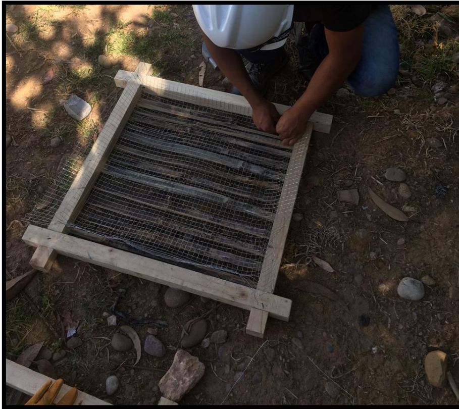
Fotografía 4: relleno de mortero
