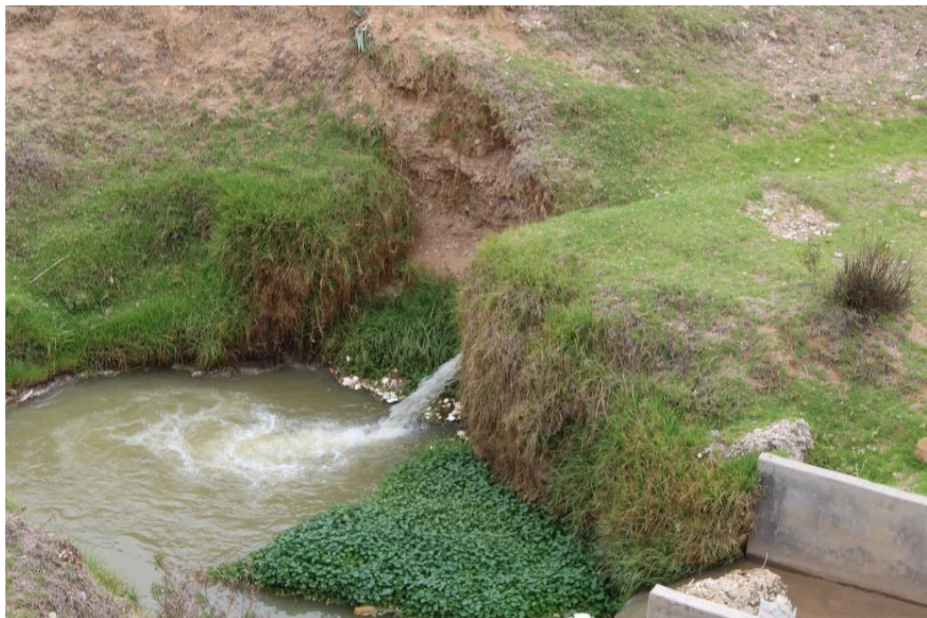
Fotografía 04. Efluente final de la planta de tratamiento de aguas residuales municipales de Quiullacocha, Sicaya - Huancayo.
