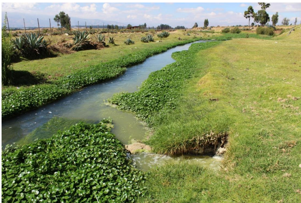
Fotografía 09. Punto de toma de muestra del efluente final de la PTAR Alcas - Sicaya para la realización del análisis de E. coli.
