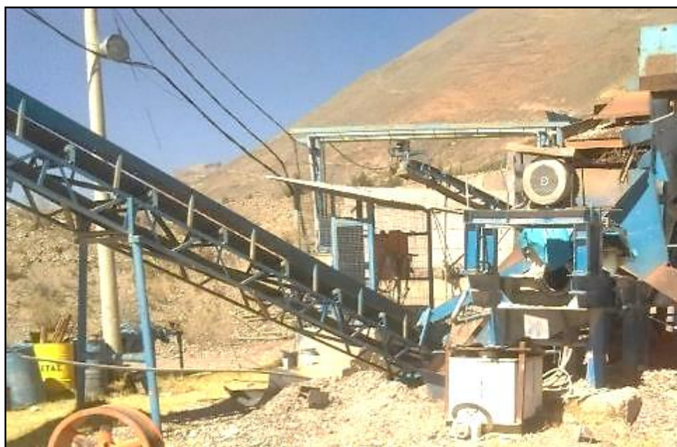
Figura 6. Planta chancadora de Chupuro. Toma propia, 2020.
