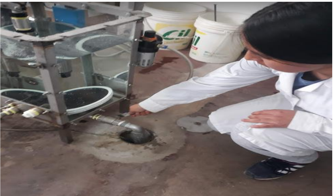
ANEXO 5. Descarga del tanque de aireación
