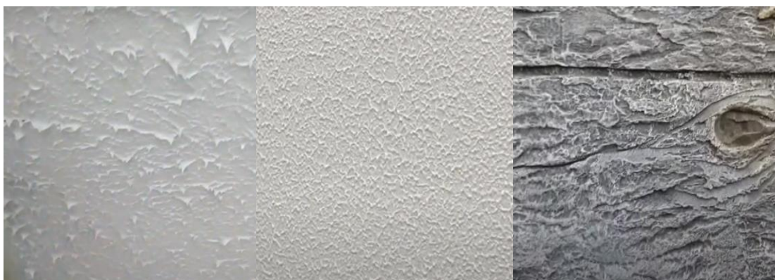
Figura 2.3 Tipos de acabado texturizado por escarchado, rodillo y moldes respectivamente.
