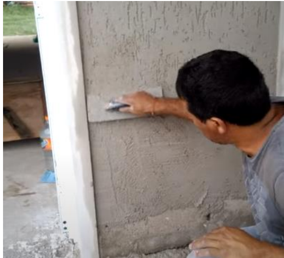
Figura 1.2 Proceso de texturizado realizado con llana
