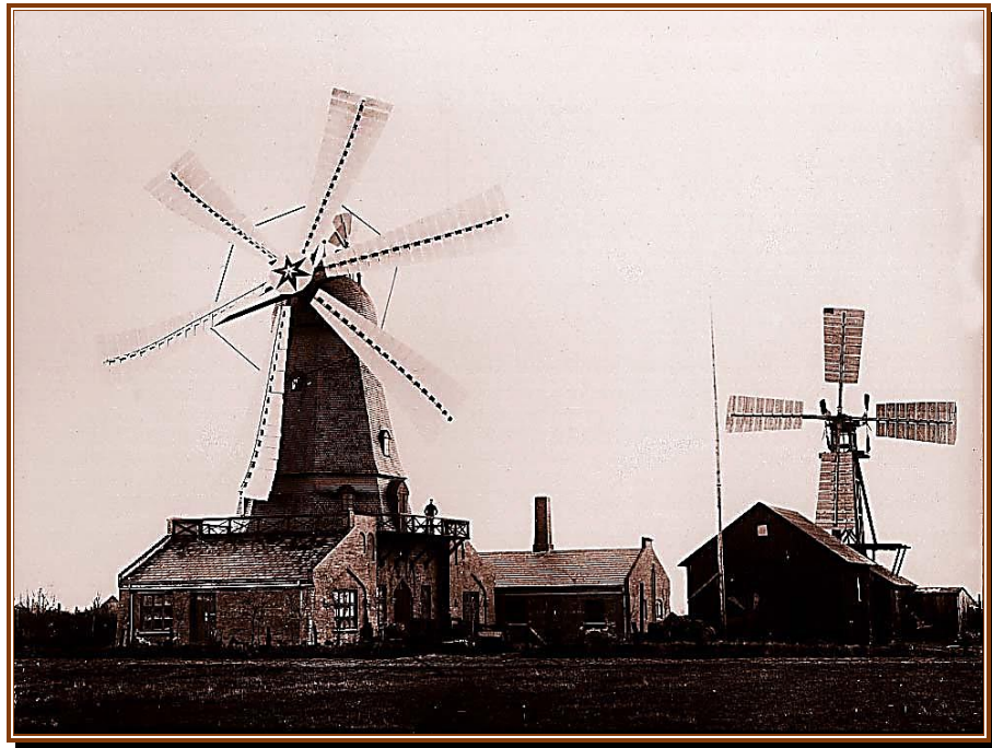
Fig. 07. Los aerogeneradores de la Cour, fuente: WINDPOWER
