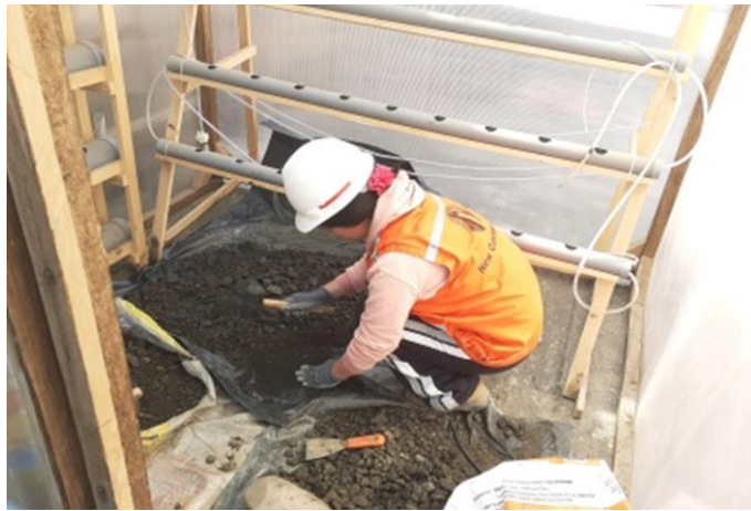
Fotografía 03. Chancado del suelo contaminado con hidrocarburos.
