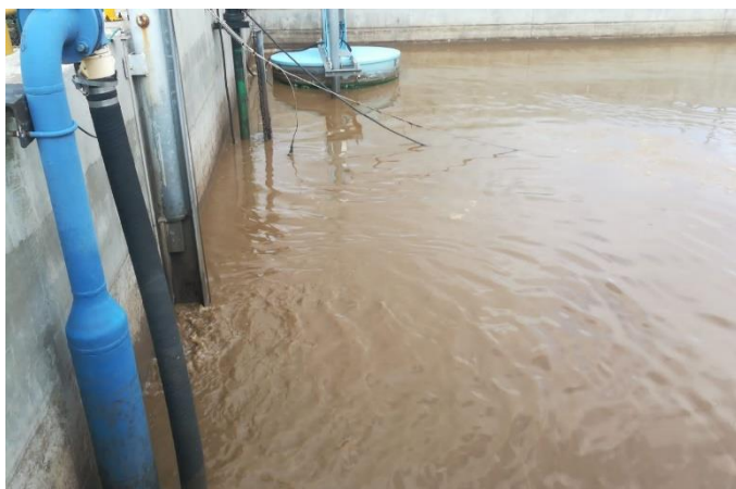
Figura 14. Inspección de burbujeo.
