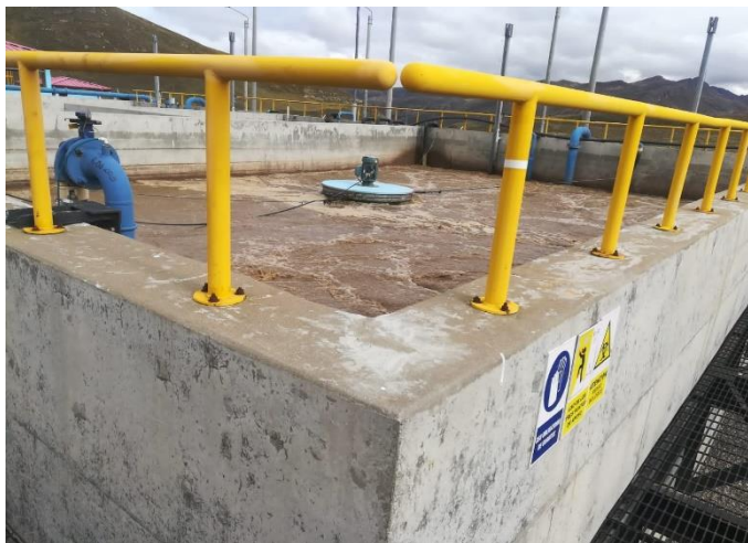
Figura 17. Funcionamiento de los difusores.
