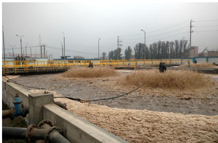
Figura 01. Construcción de la Planta de Tratamiento de Agua Residuales Domésticas - San Juan de Lurigancho.
