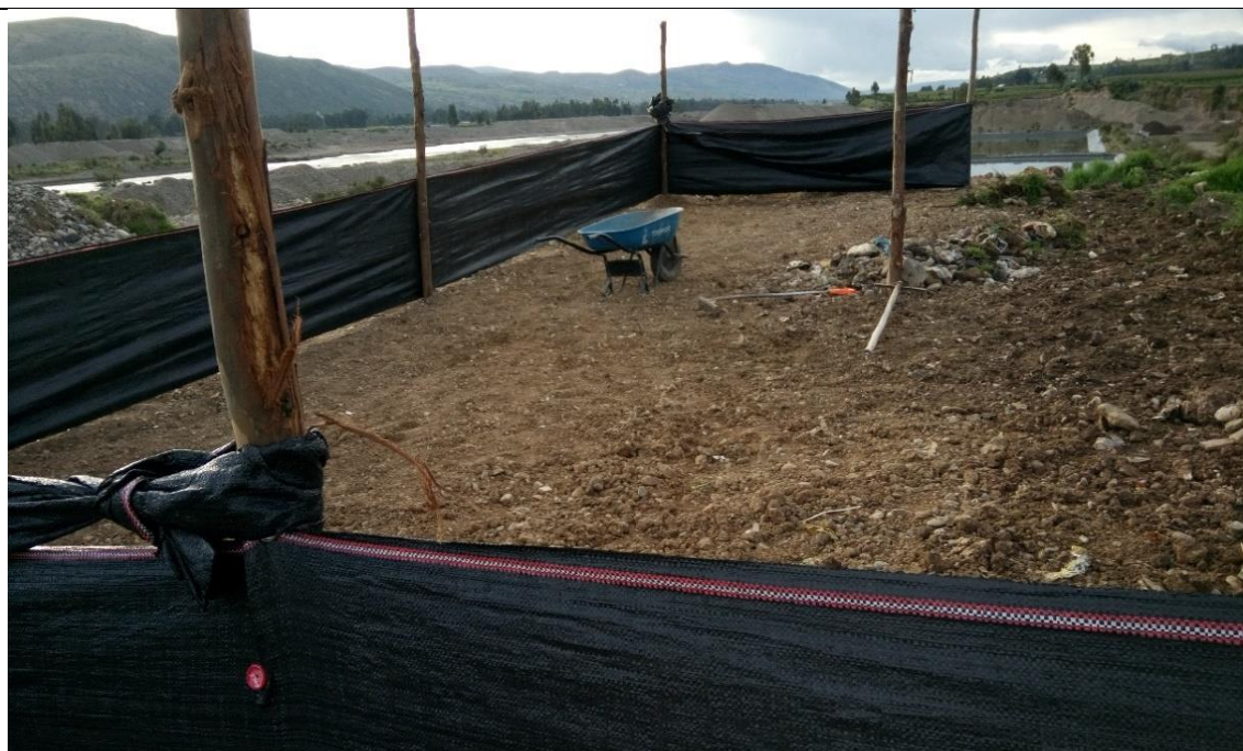
FOTO 2. ACONDICIONAMIENTO DEL TERRENO
