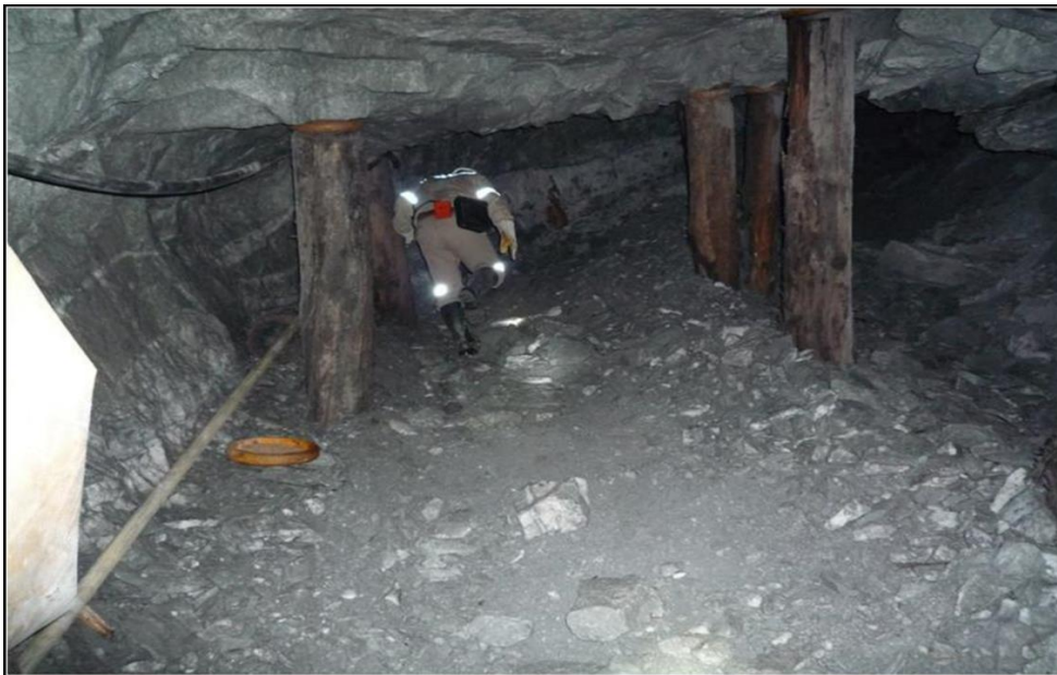
Figura 57. Sostenimiento con puntales y cabezales Jack Pot del método de minado Long Wall.
