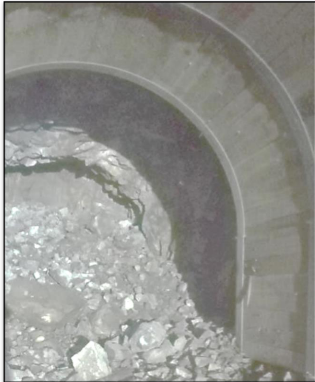
Figura 2: Uso de Cimbras Rampa (-) 440.
