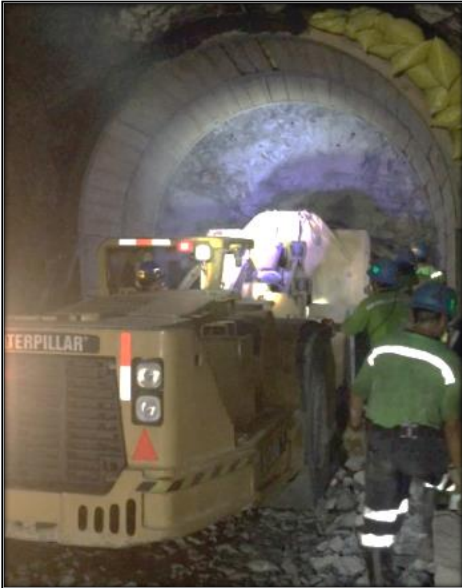
Figura 20: Fotografía de limpieza del frente.
