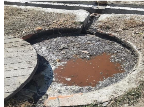
Fotografía 16. Depósito de lixiviado con cal.
