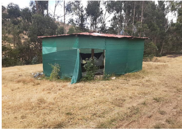
Fotografía 17. Condición de la caseta.
