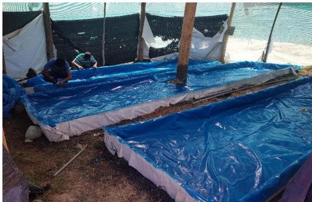
Fotografía 19. Acondicionamiento de las cajas.
