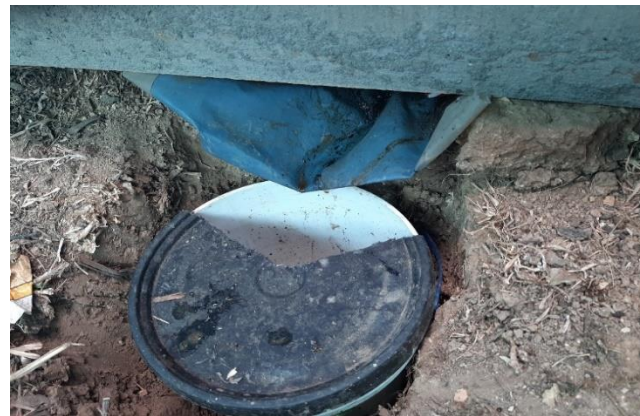
Fotografía 20. Balde para acumulación de lixiviados.
