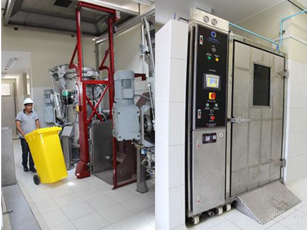
Figura 25. Espacio para tratamiento de residuos hospitalarios
