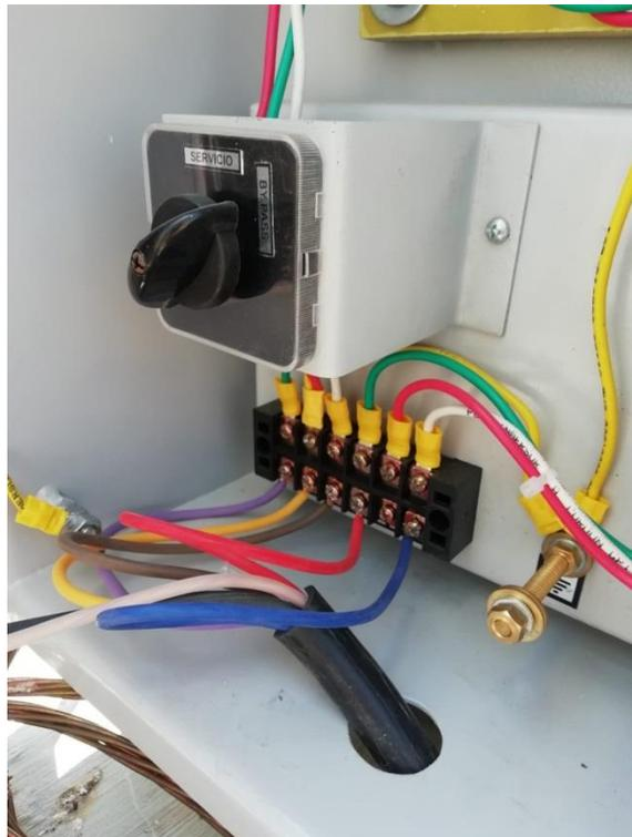
**Figura 34. Conexionado en bornera de transformador de medida**
