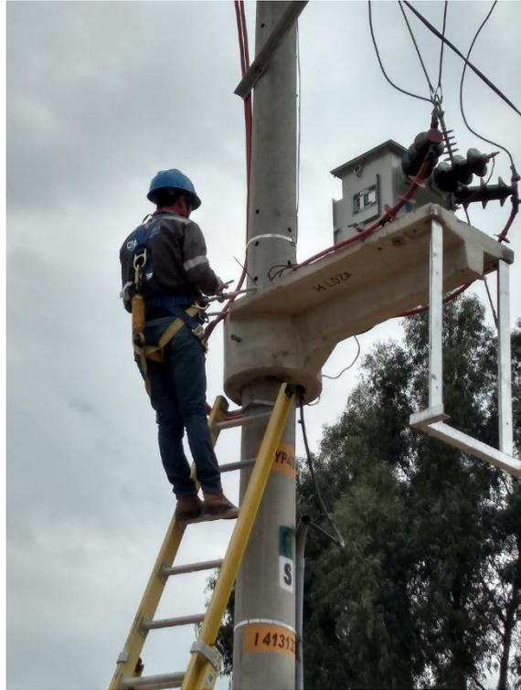
**Figura 31. Empalme en bornera de transformador de medida**
