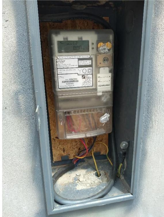
Figura 35. Conexionado en bornera de medidor
