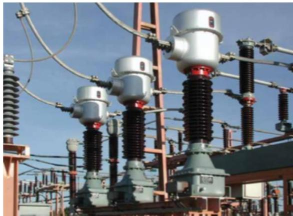
Figura 16. Transformadores de protección. Tomada de [grupoteimexico.com.mx](http://grupoteimexico.com.mx)
