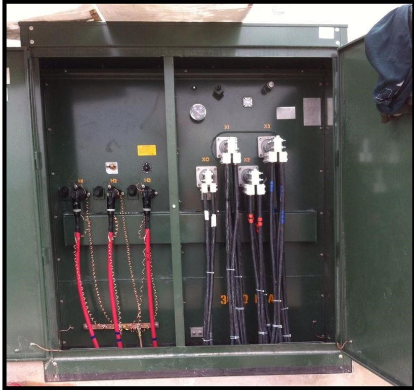
*Figura 11. Subestación pedestal*
