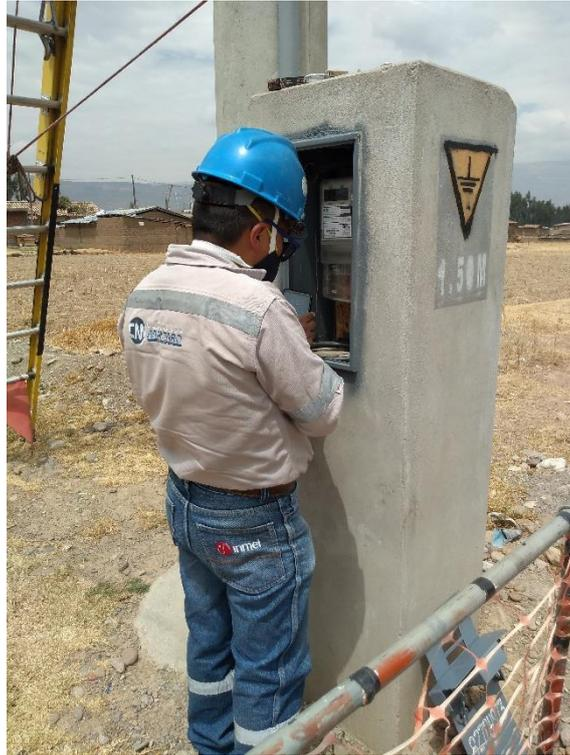
**Figura 33. Empalme en bornera de medidor**
