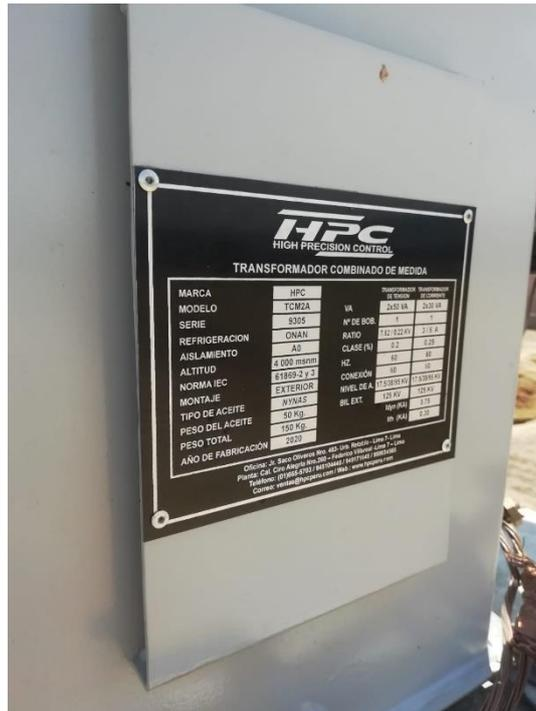
Figura 27. Placa de datos del transformador de medida
