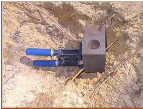
Figura 61. Conector de varilla de cobre.
