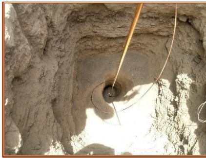
Figura 54. Instalación de dos electrodos separados 1 metro.
