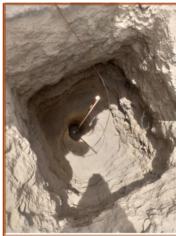
Figura 52. Instalación del electrodo.
