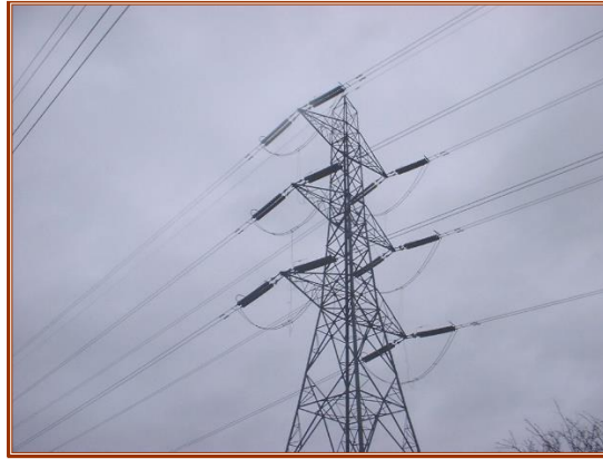
Figura 22. Apoyo de anclaje doble de doble terna.
