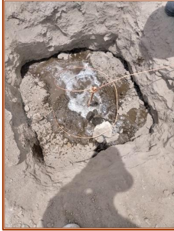
Figura 53. Instalación de dos electrodos separados 0.6 metros.
