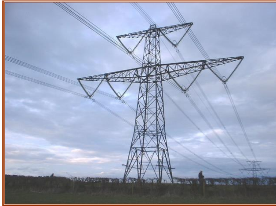
Figura 20. Apoyo de alineación cuádruple de doble terna.
