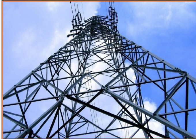
Figura 25. Apoyo de celosía de perfiles laminados de celosía de entramado. Fuente: Internet
