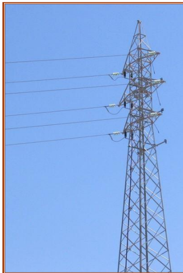
Figura 23. Apoyo simple de doble terna de fin de línea.
