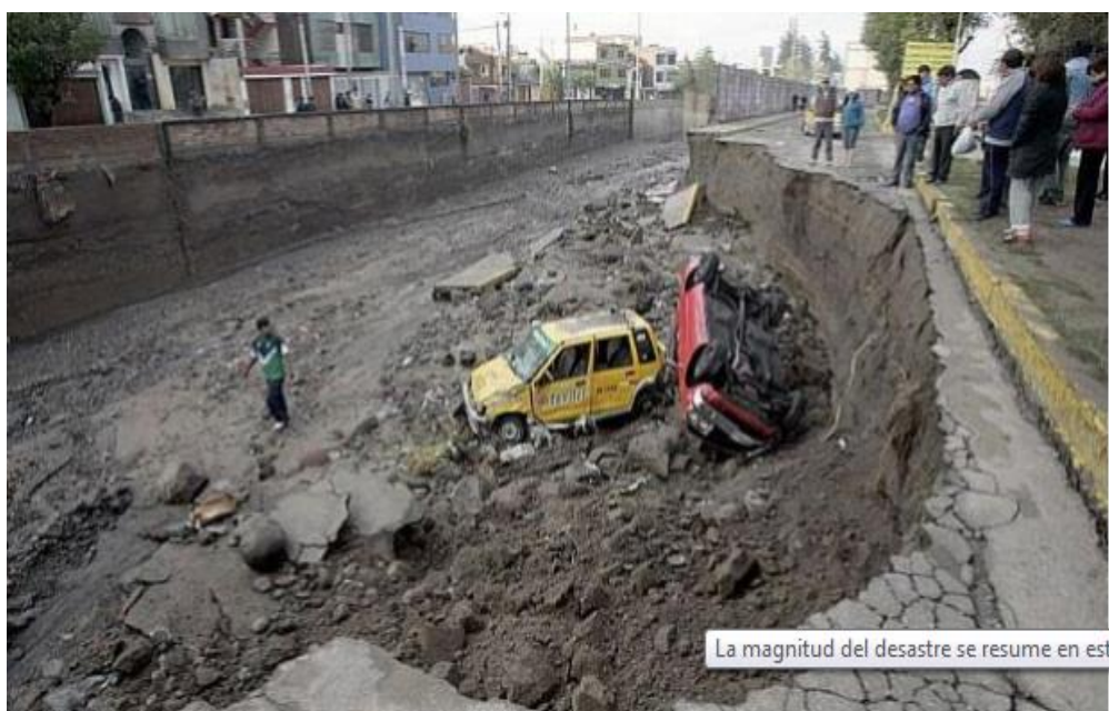
Figura 2. Colapso de vía - Av. Venezuela cercado de Arequipa
