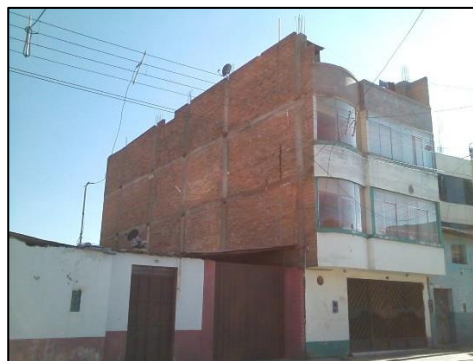
Figura 2: Vivienda Autoconstruida, se puede apreciar los muros portantes en la dirección longitudinal y en la transversal que es la fachada solo pórticos. Fuente: Elaboración propia.
