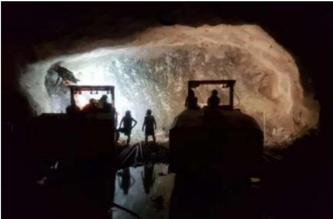
Figura 6. Sistema de explotación mecanizado TJ2927 – Nv. 1915 - Balcón
