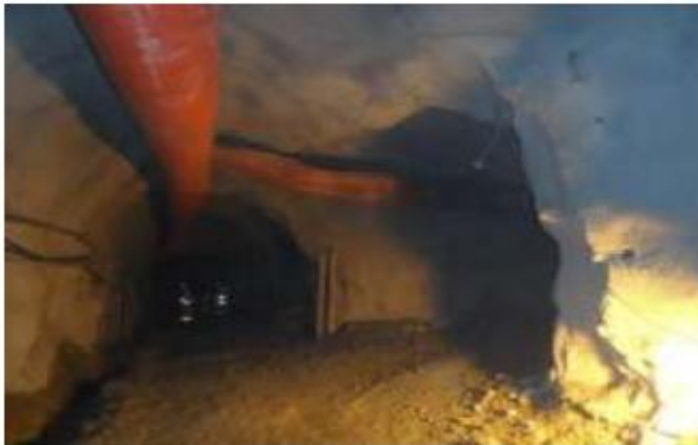
Figura 8. Intersección de labores con shotcrete y pernos sistemáticos
