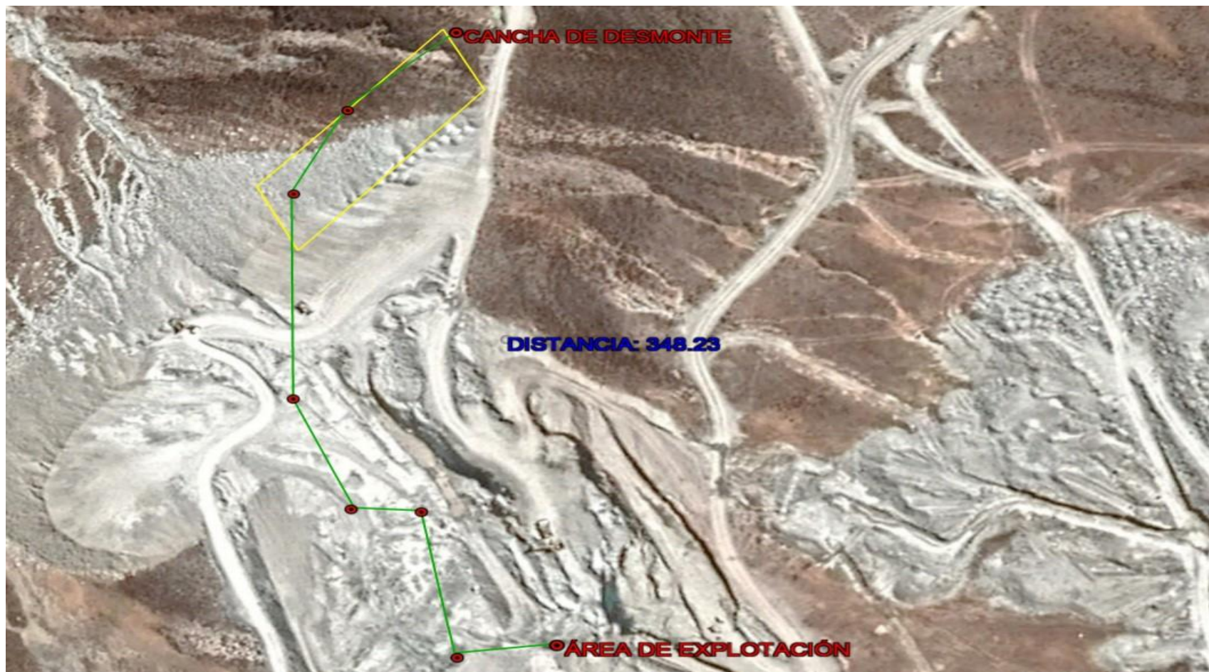
Figura 16. Área de explotación de desmonte ejecutado, periodo 2019 - 20, UEA Jesús Poderoso N°8
