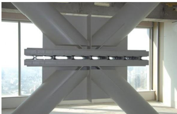
Figura 7. Disipador de fricción
