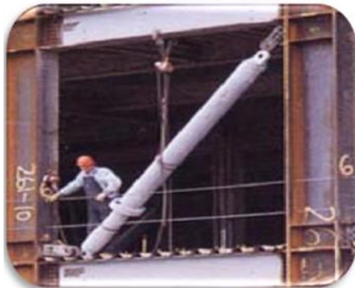
Figura 13. Disipador de energía de fluido viscoso
