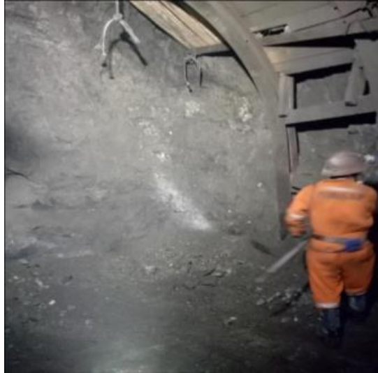
Figura 16. Se limpia la carga del frente y se desata
