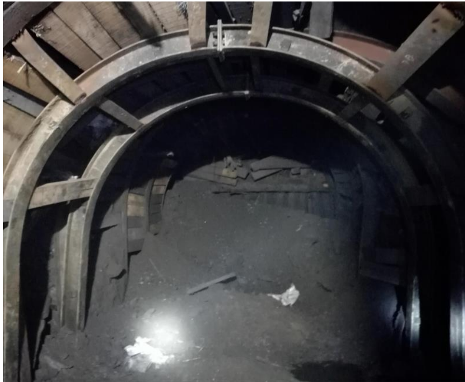
Figura 30. Refuerzo de cimbras, posterior al disparo
