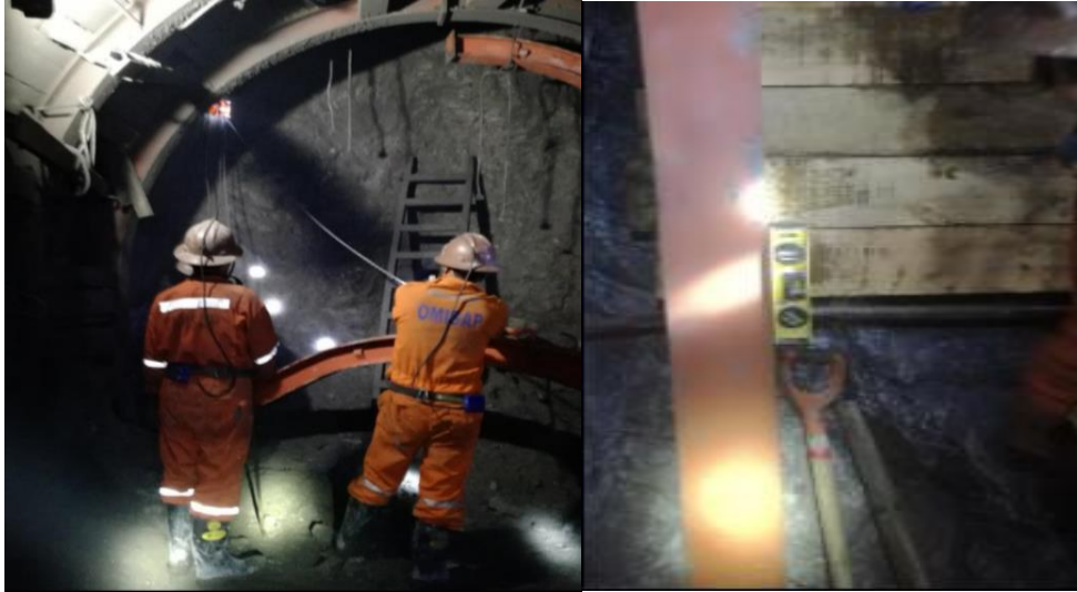
Figura 20. Colocado del tecele al segmento para su izaje y a la derecha la nivelación de cimbra
