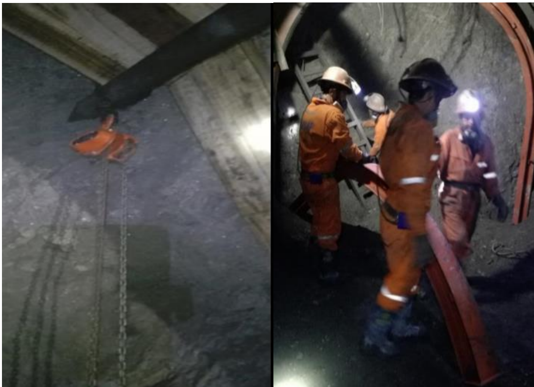
Figura 19. Instalación del tecele de 1 t y al derecho traslado y posicionamiento del primer segmento para su instalación.
