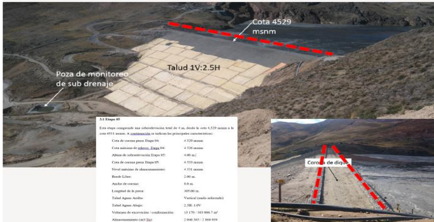
Figura 41. Relavera de la unidad minera Yauricocha Tomado del Departamento de Planeamiento
