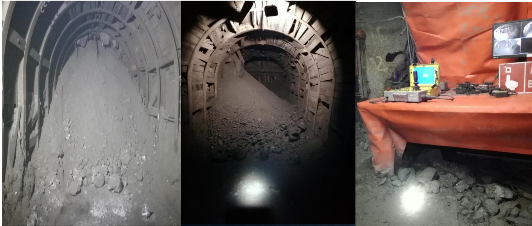
Figura 27. Disparo mediante taladros largos en el método de minado Sublevel Caving, Cuerpo Esperanza
