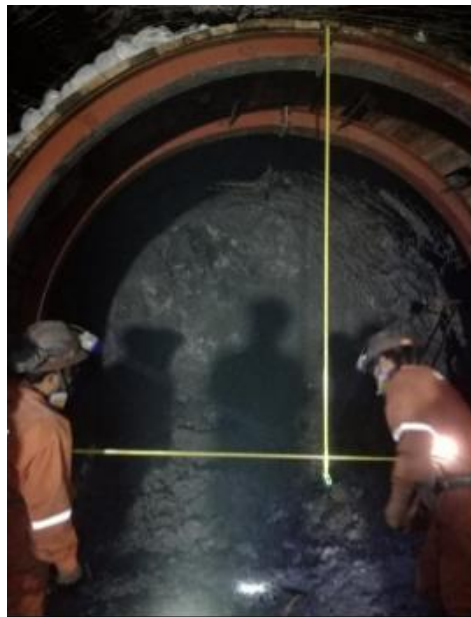
Figura 17. Punto de dirección y gradiente para iniciar el picado de patilla
