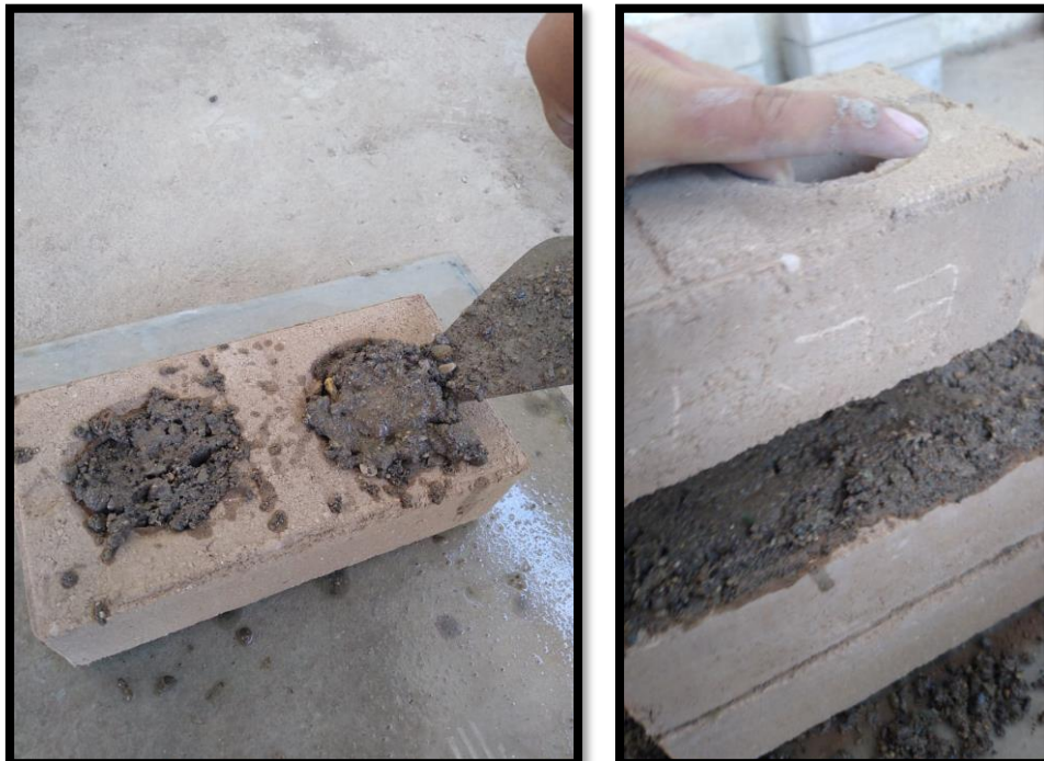
Fotografía 15. Asentado de BTC
