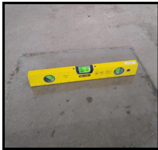
Fotografía 13. Superficie limpia y horizontal
