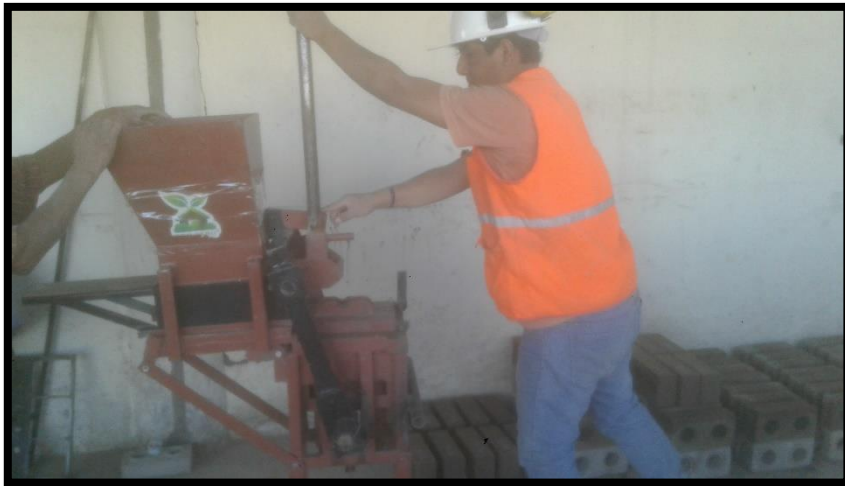
Fotografía 06. Compactación de mezcla mediante máquina de compresión mecánica
