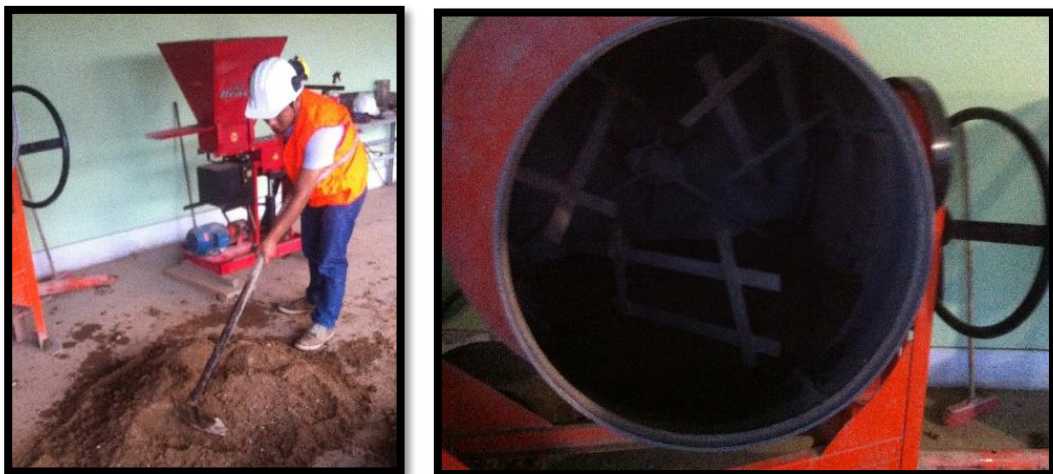
Fotografía 10. Preparación del suelo (izquierda); Mezcla en máquina (derecha)
