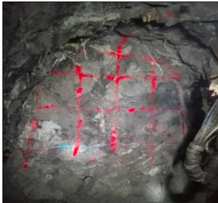
Figura 7. Pintado de la malla de perforación antes de aplicar la nueva malla Tomado de Pablo Gálvez Paucar – Diseño de perforación y voladura en frentes Exsa (7)
