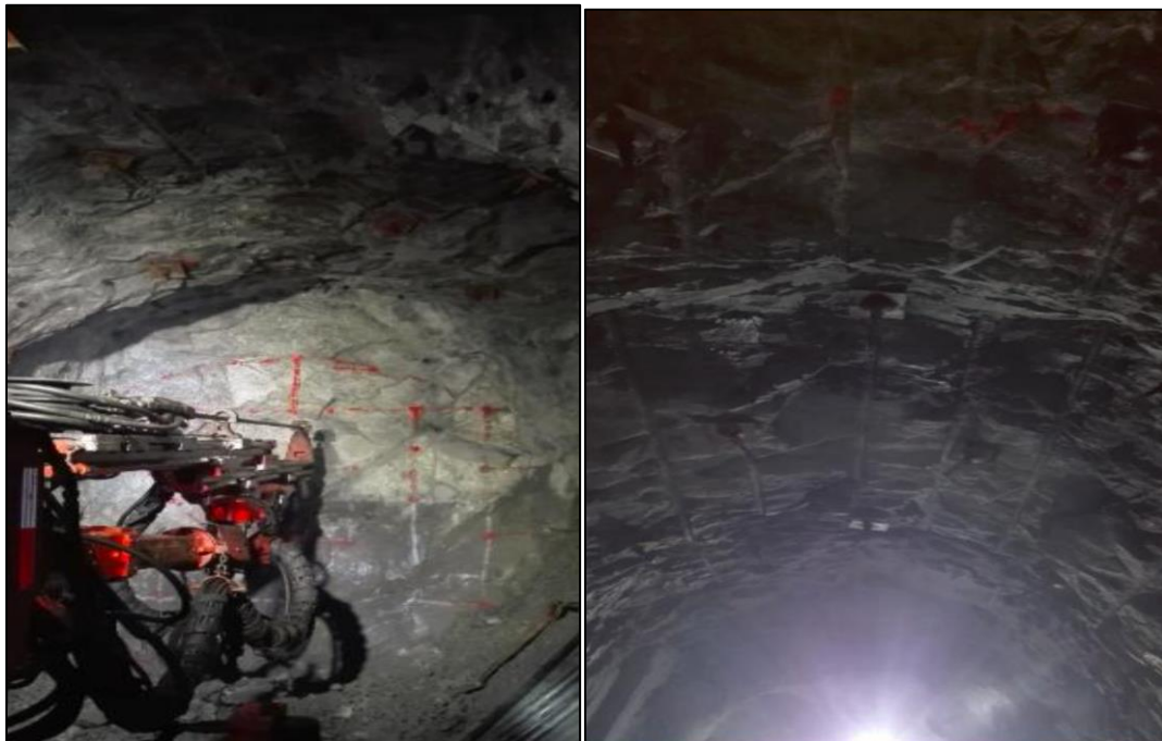
Figura 14. Resultados de perforación y voladura aplicando la nueva malla
