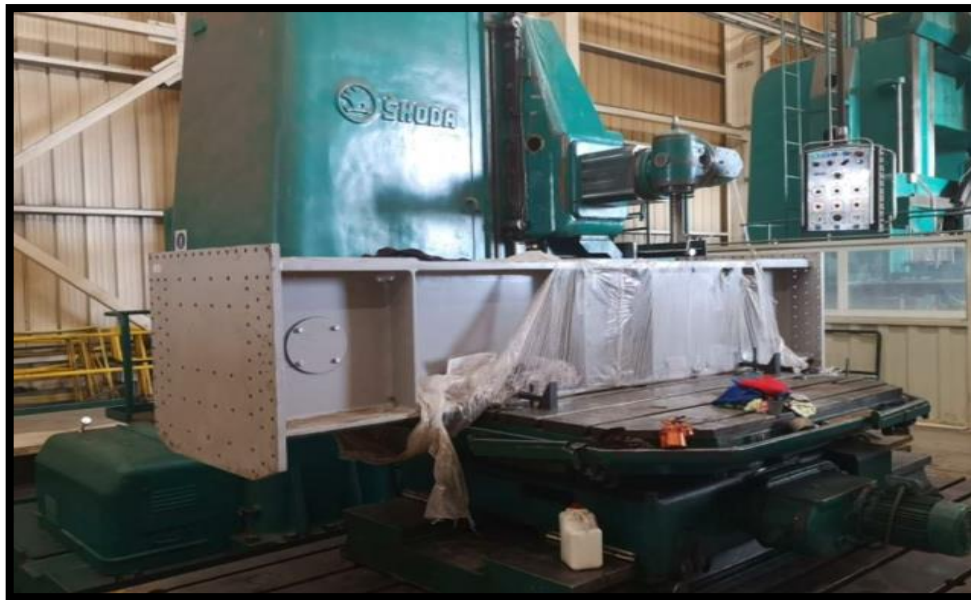
Figura N°13. Reparación de componente en Mandrinadora
