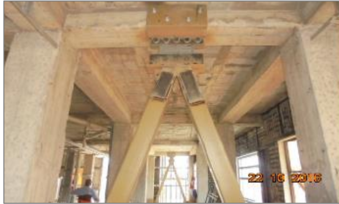
Figura 4. Instalación del disipador sobre diagonales metálicas tipo Chevron Tomada de Estructuras y Proyectos S. L., Luis Bozzo
