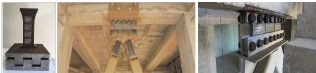
Figura 32. Conector tipo peine e instalación de disipador de corte SLB Tomada de Estructuras y Proyectos S. L., Bozzo, 2017
