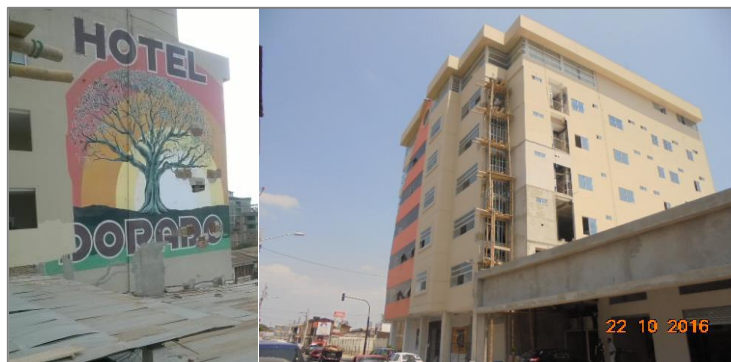
Figura 3. Hotel Ceibo Dorado caso de reforzamiento estructural Tomada de Estructuras y Proyectos S. L., Luis Bozzo
