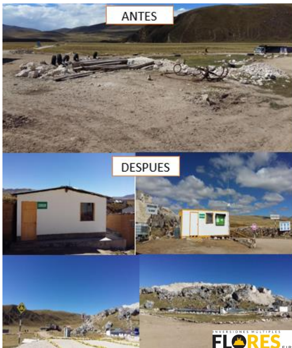
Figura 2 Mejoramiento de las condiciones habitables Empresa Flores E.I.R.L. Nota: Fotografías extraídas del Informe SSOMA N° 01-2019 (Dolores, 2019)
