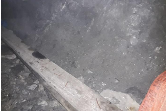
Figura 07. No hay presencia de dispositivos de segregación.
