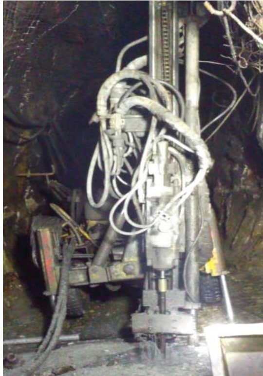
Figura 5. Perforación vertical en negativo con raptor
