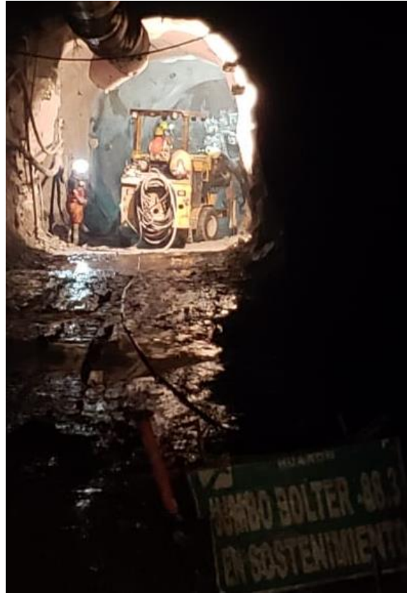
Figura 6. Sostenimiento con bolter
