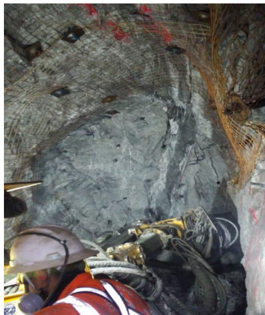
Figura 4. Perforación horizontal con jumbo
