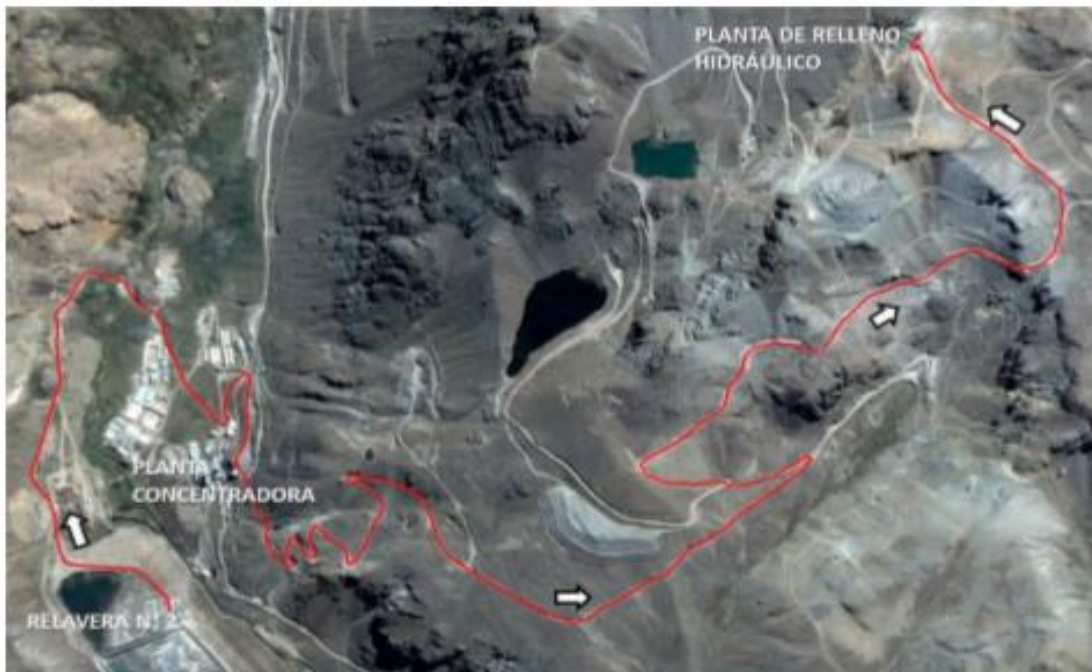
Figura 22. Ruta de transporte de relleno hidráulico en volquetes desde los hidrociclones hasta la planta de relleno hidráulico.
