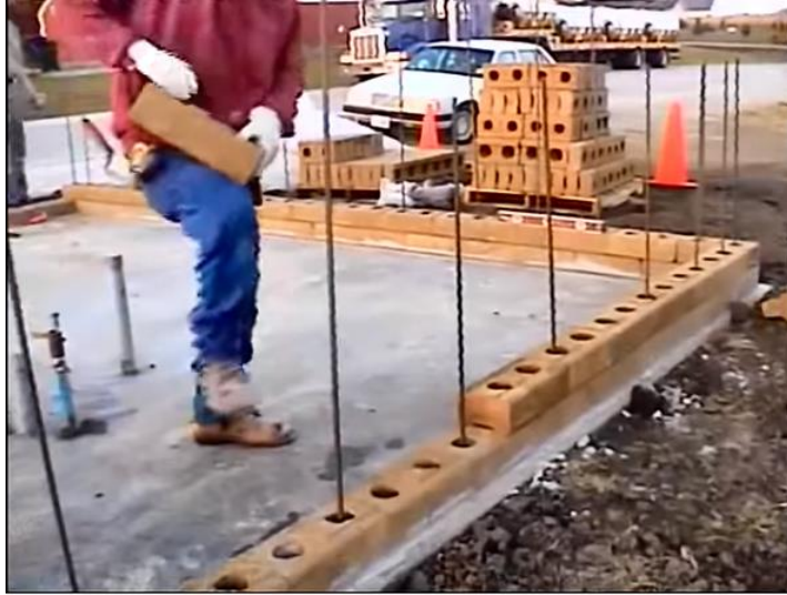
Figura 13: colocado de BTC para muros, con apoyo de acero verticales
