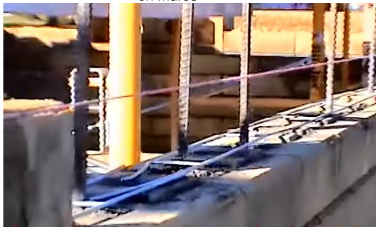
Figura 14: Nivelación mediante un hilo para el colocado de los BTC en muros
