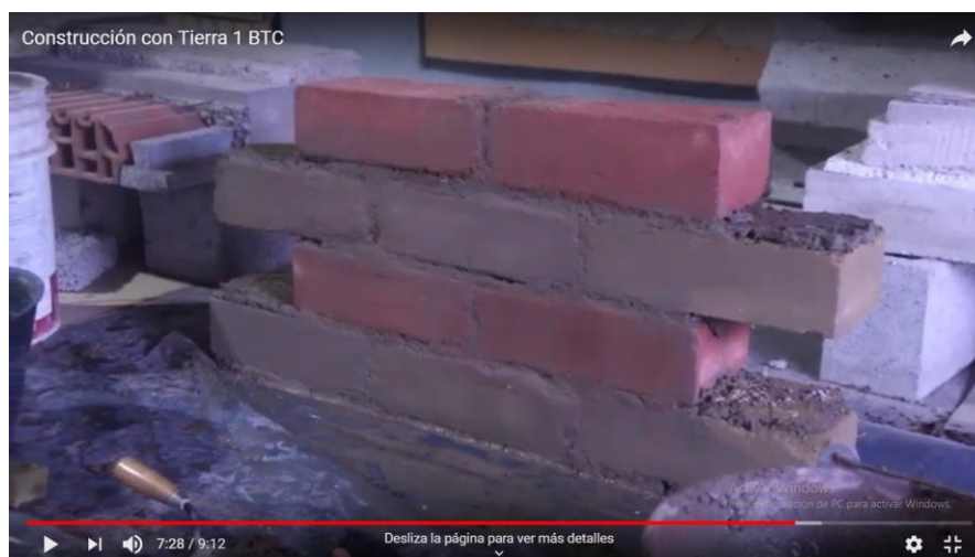
Figura 1: Demostración de una construcción de muro con BTC pigmentado
