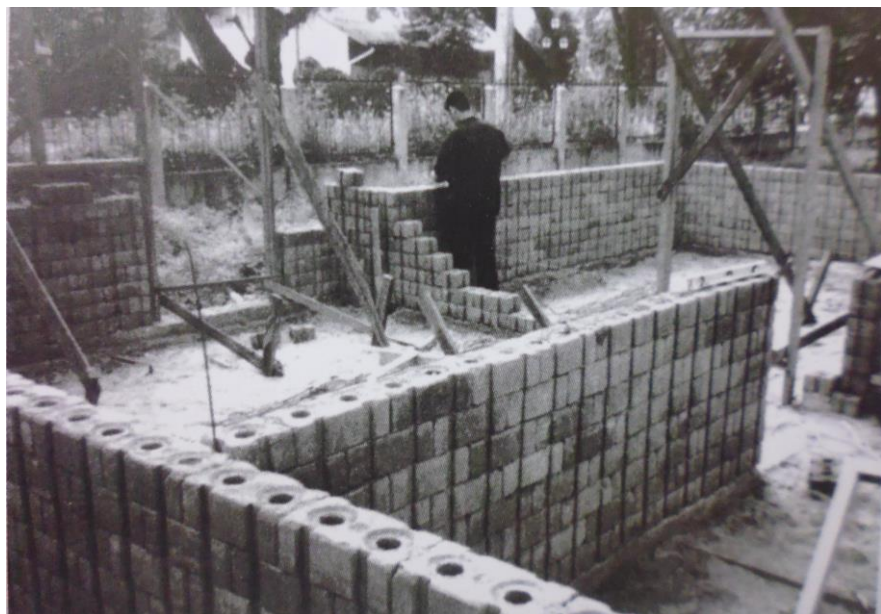
Figura 5: Formas de Construcción con BTC y Cañas de Bambú
