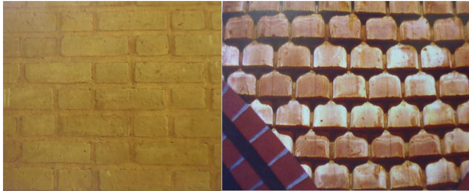
Figura 9: Acabados Cara Vista de BTC
