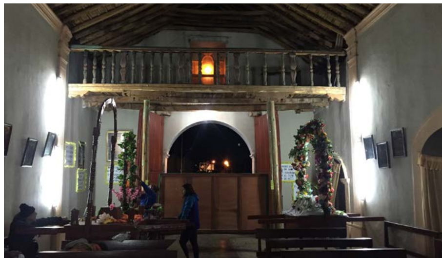
Figura 18. Nave principal, sotocoro y coro desde el interior
