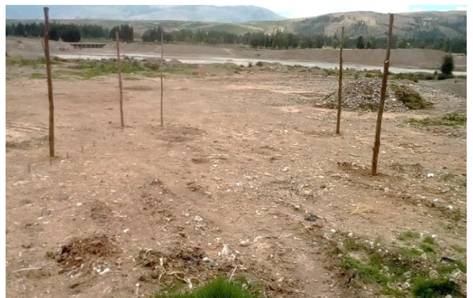
FOTOGRAFÍA N°6-Palos para el cerco de protección
