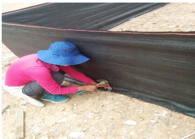
FOTOGRAFÍA N°8-Cerco de protección con mantada
