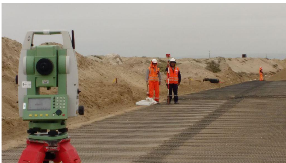
Figura 13. Trazo y replanteo
