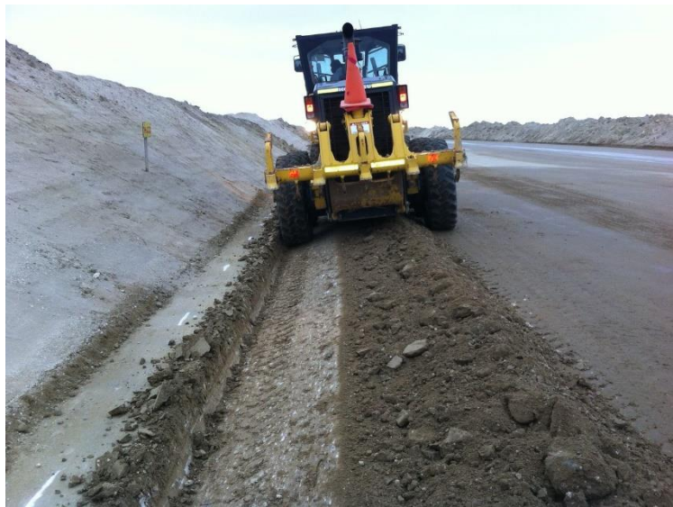
Figura 20. Apertura de cunetas con motoniveladora
