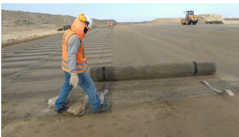
Figura 14. Colocación de geomalla
