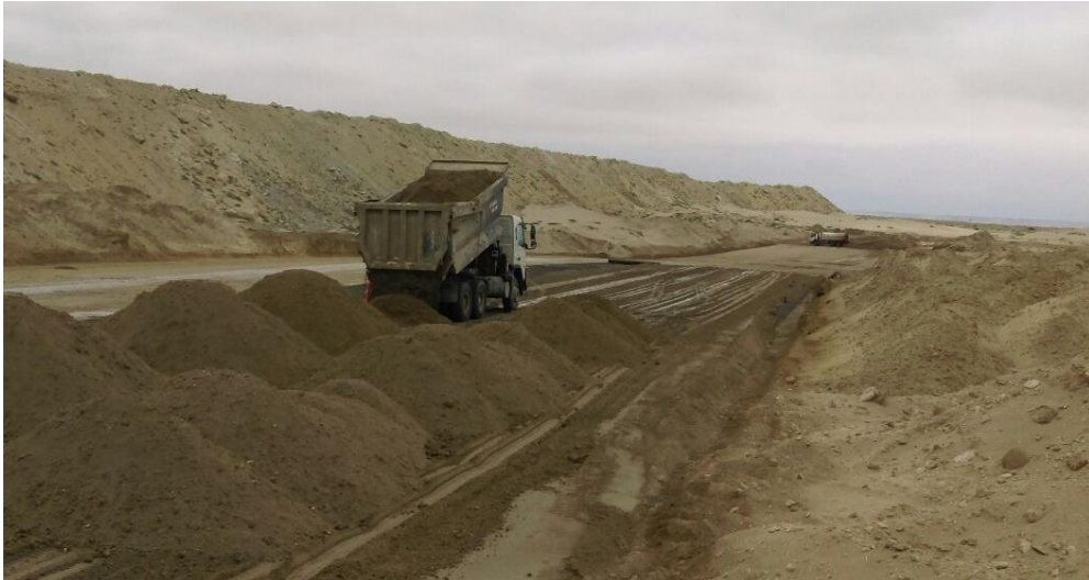
Figura 15. Descarga de material en plataforma de relleno
