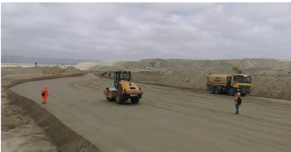
Figura 17. Compactación de plataforma de relleno
