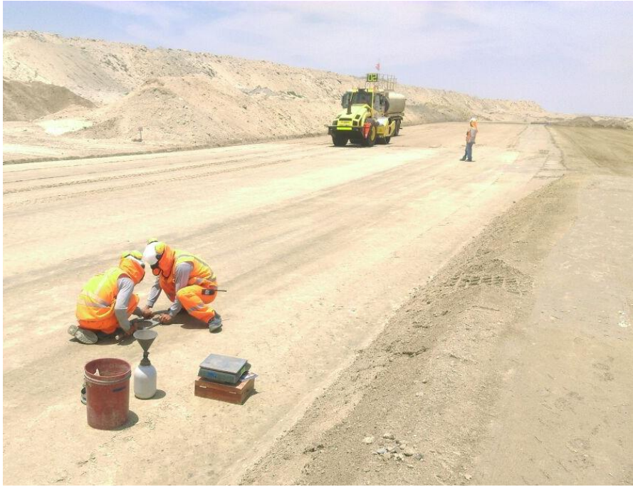
Figura 18. Ensayo de densidad de campo
