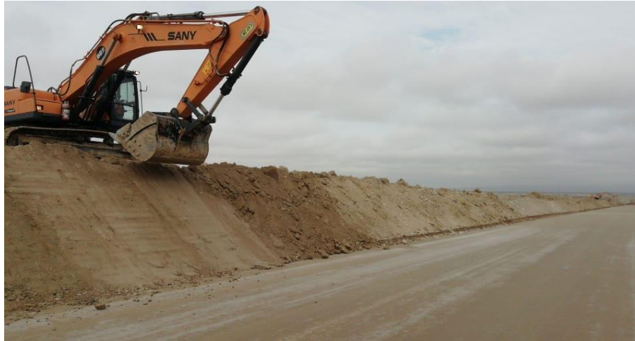
Figura 19. Construcción de bermas de seguridad
