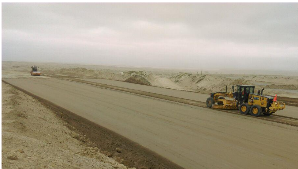
Figura 16. Conformación de plataforma de relleno
