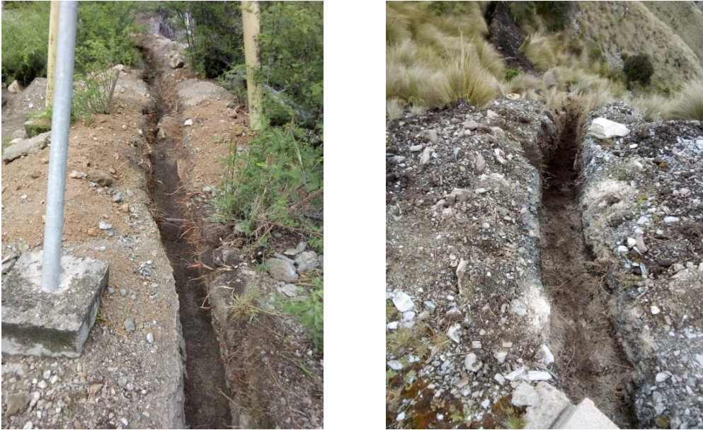
Figura 54. Excavación de zanja para contrapeso horizontal
