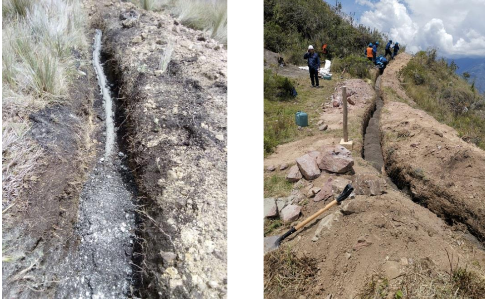
Figura 60. Rellenado con tierra orgánica y bentonita
