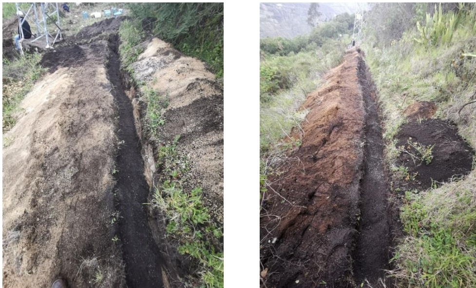
Figura 56. Primera capa con bentonita y tierra negra
