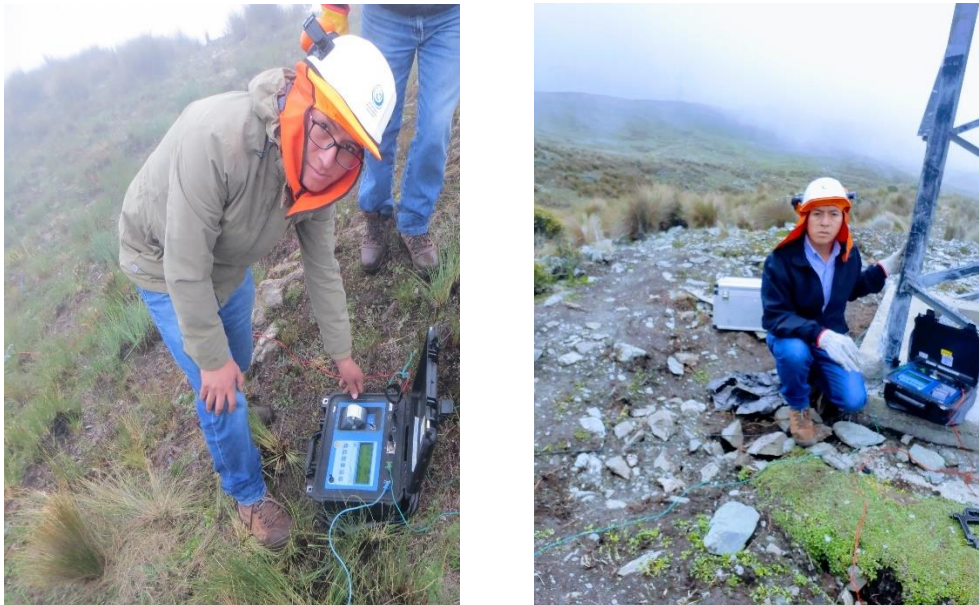
Figura 68. Tomando la medición final de resistencia de puesta a tierra
