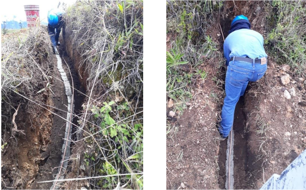
Figura 58. Tendido de conductor desnudo de 70 mm 2
