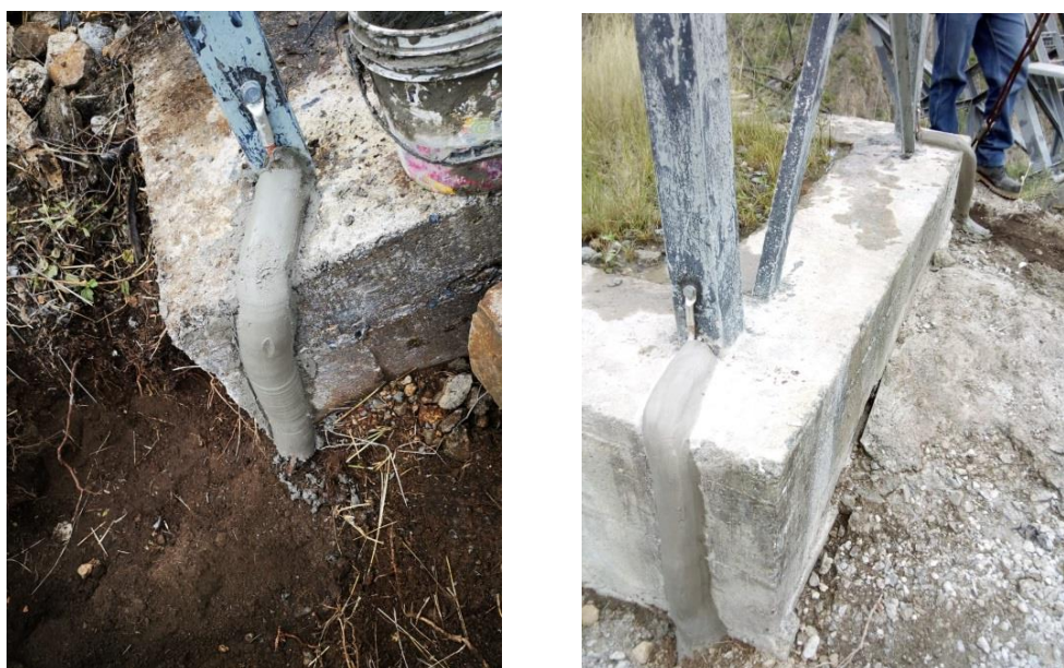
Figura 63. Instalación de conductor bimetálico
