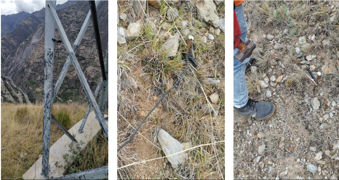
Figura 67. Clavado de estacas y engarce a la estructura
