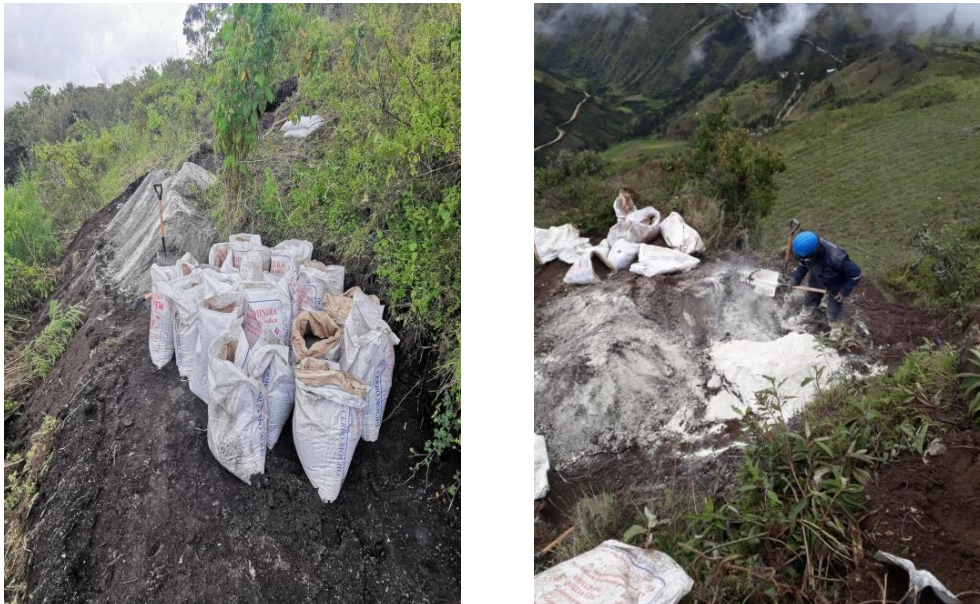
Figura 55. Preparación base y relleno con bentonita y tierra negra
