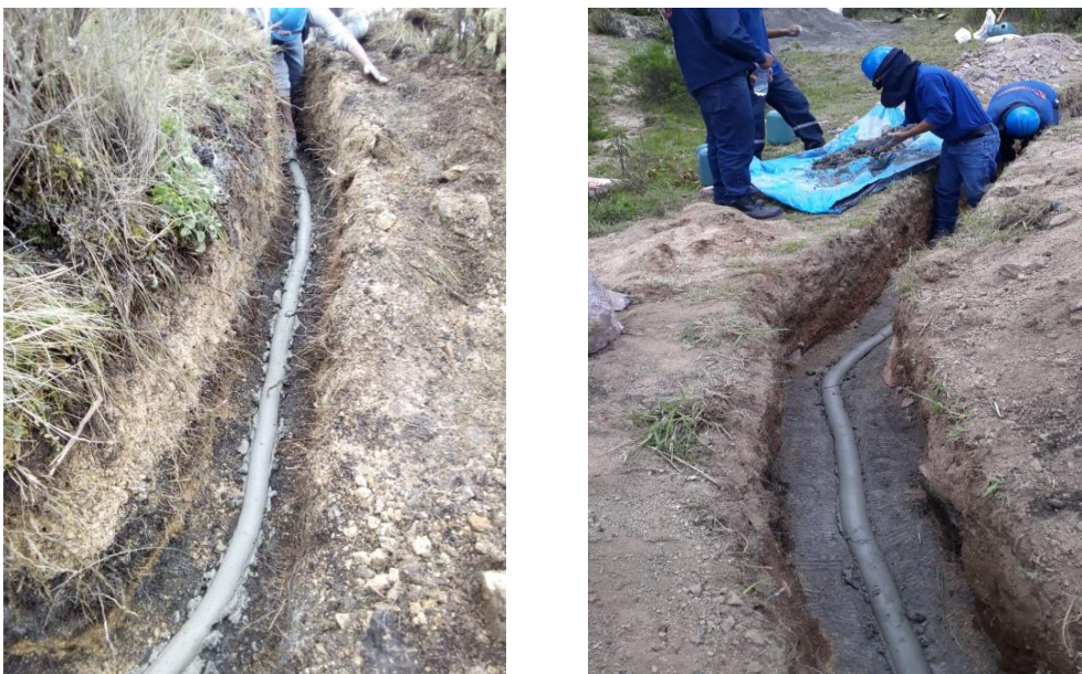
Figura 59. Recubrimiento del conductor con cemento conductivo
