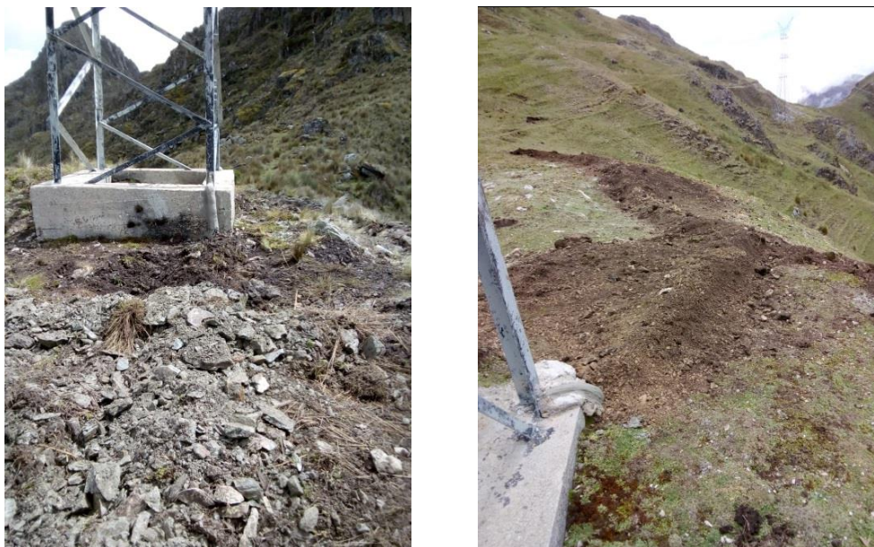
Figura 62. Rellenado de la última capa con misma tierra sacada inicialmente
