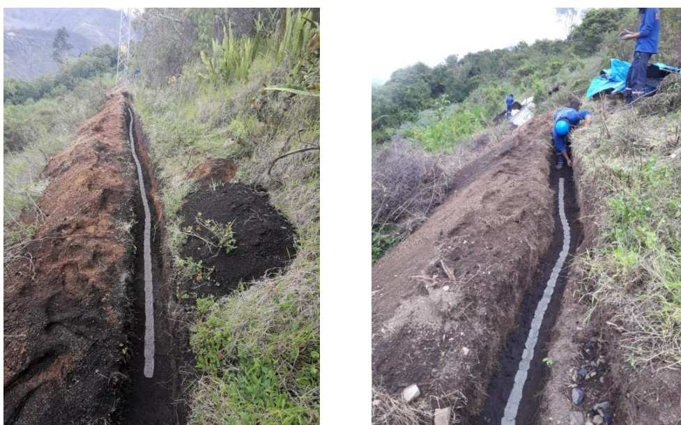
Figura 57. Base de cemento conductor en zanja
