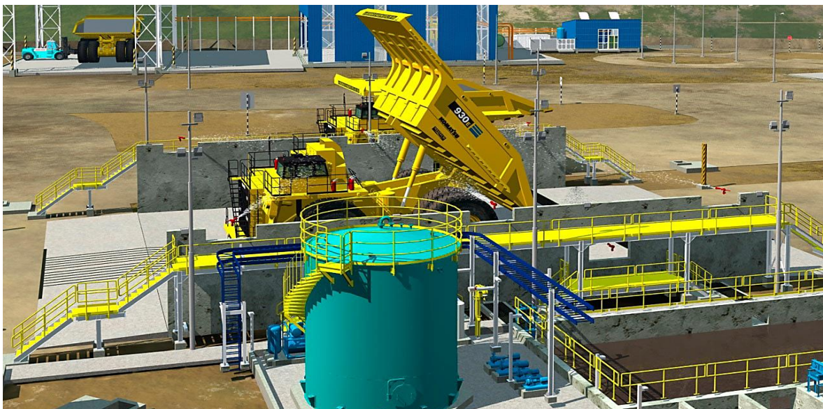
Figura 26: Área 134- lavadero de camiones
